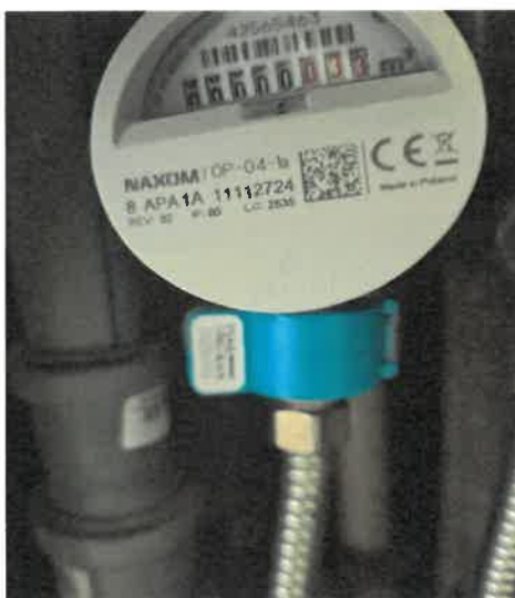
Fot. Wymieniony wodomierz z nakładką do odczytu radiowego.
