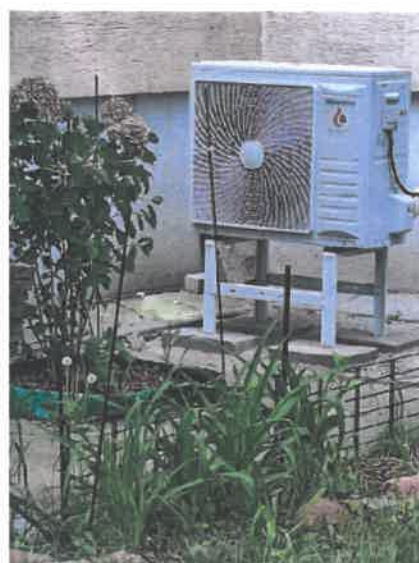
Fot. Pompa ciepła zamontowana w węźle cieplnym budynku i agregat pompy przy ul. Sterniczej 131
