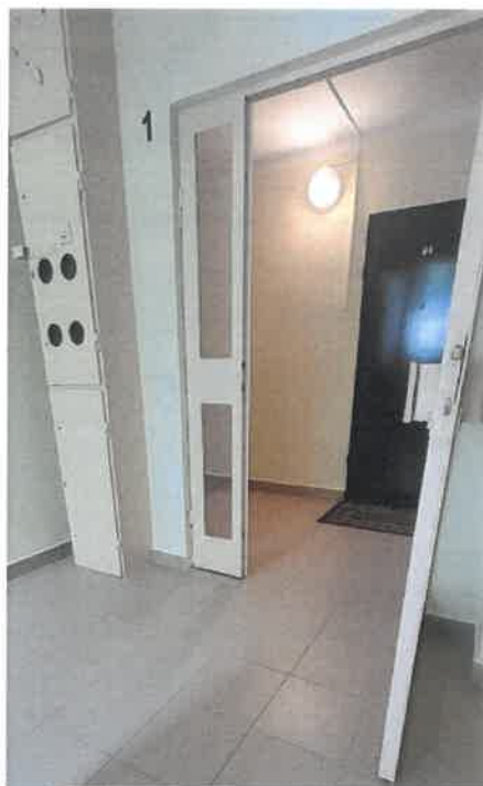
Fot. Lazurowa 6 kl. III piętro I- ułożony gres na posadzce i odnowiona klatka schodowa
