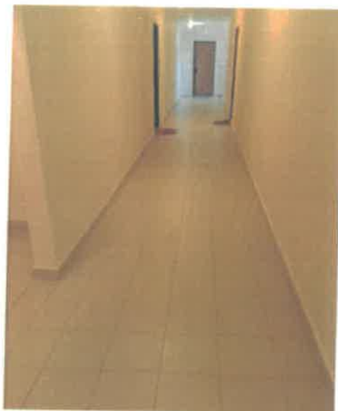
Fot. Pomalowane ściany klatki schodowej piętro IV
