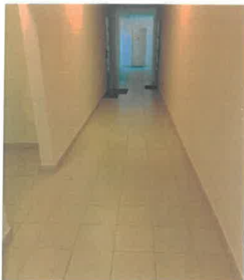
Fot. Lazurowa 6 kl. IV piętro I- ułożony gres na posadzce
