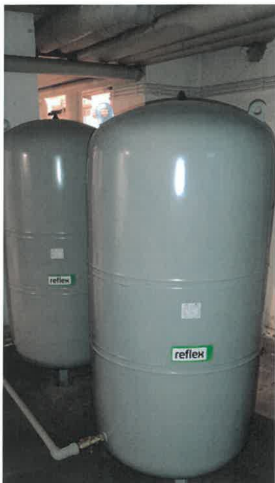
Zdjęcie- Wymienione naczynia ciśnieniowe wyrównawcze na instalacji centralnego ogrzewania w budynku Rozłogi 2
