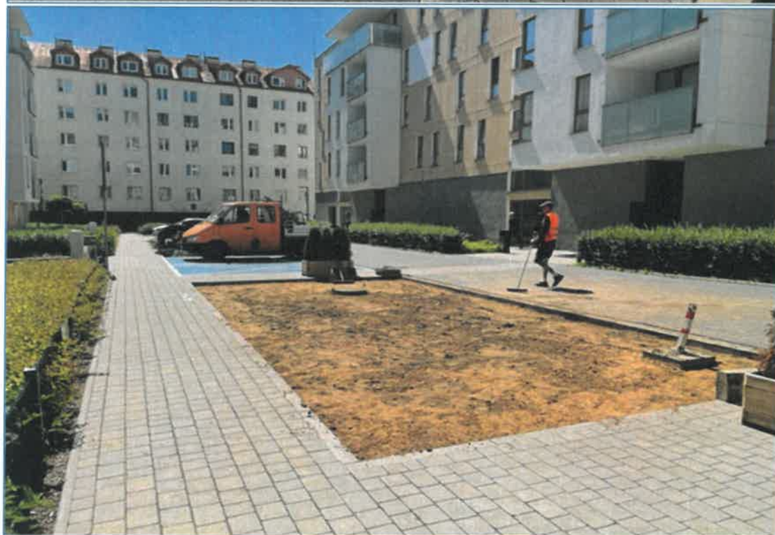
Korekta oznakowania poziomego w pasie drogowym ZDM oraz Przebudowa nawierzchni miejsc parkingowych przed budynkiem Szeligowska 6A
