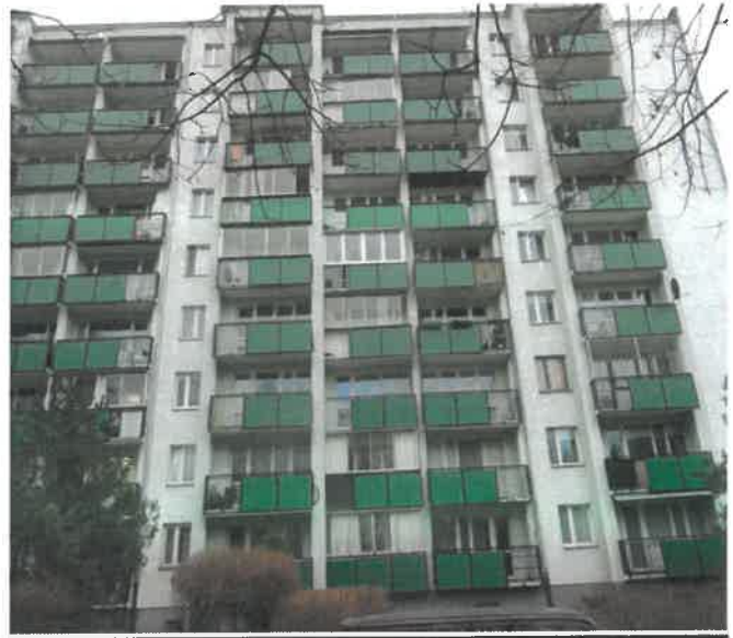
fot. balustrady balkonowe w budynku Rozłogi 6
