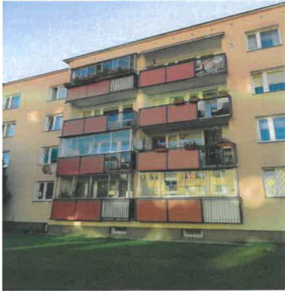
fot. balustrady balkonowe w budynku Rozłogi 4
