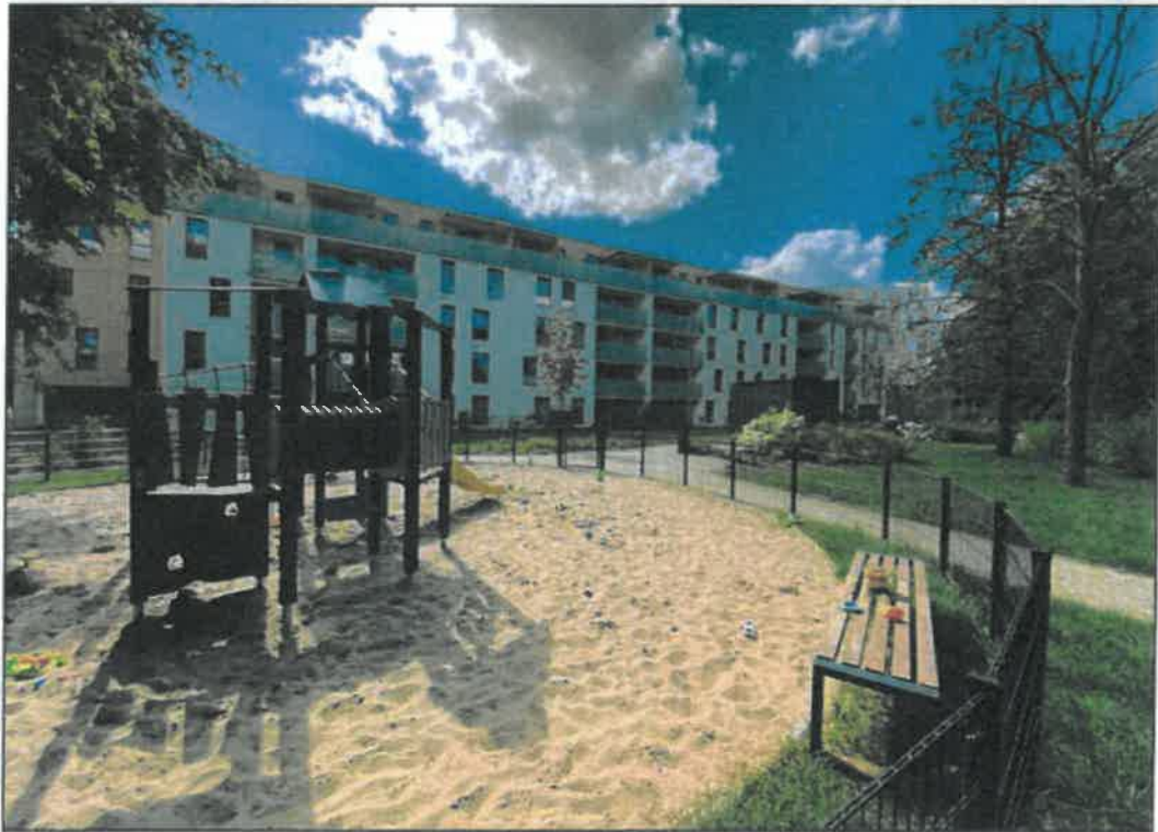
Widok ogólny budynków po przebudowie nawierzchni oraz od strony dziedzińca na plac zabaw
