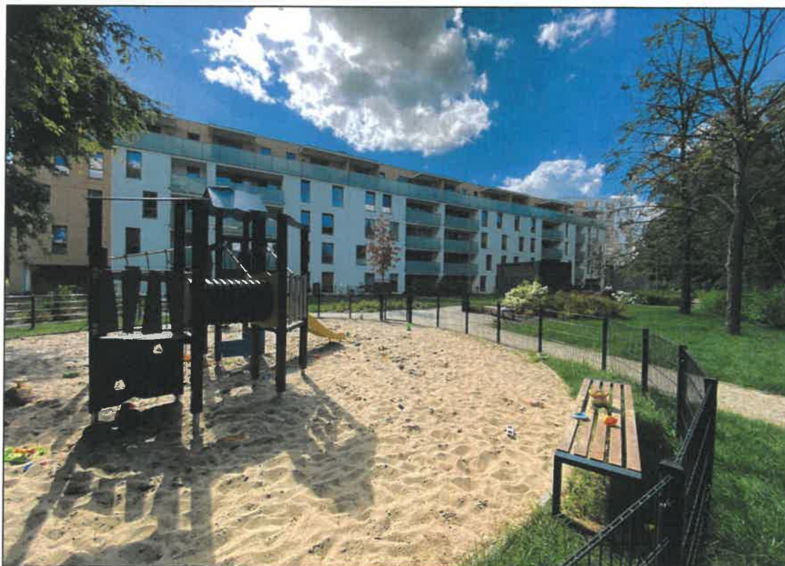
Widok ogólny budynków po przebudowie nawierzchni oraz od strony dziedzińca na plac zabaw
