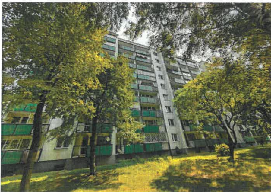
fot. balustrady balkonowe w budynku Rozłogi 6
