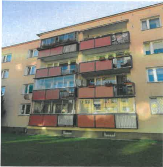
fot. balustrady balkonowe w budynku Rozłogi 4
