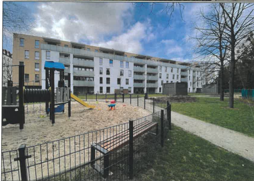
Widok ogólny budynków od strony dziedzińca i placu zabaw
