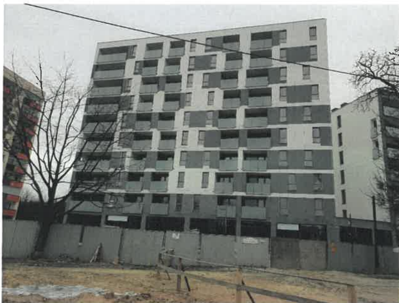
Fot.6. Widok budynku B4 od strony ul. Szeligowskiej
