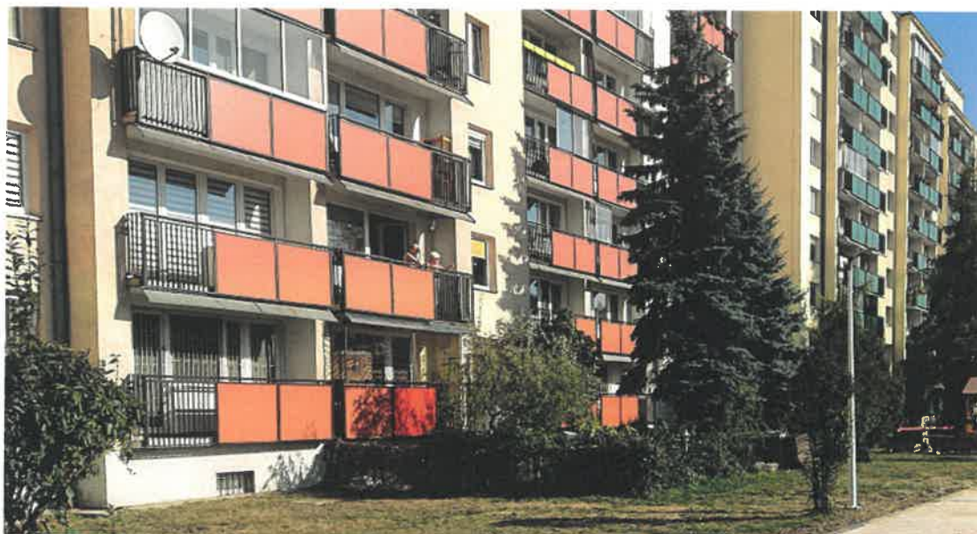
fot. Sternicza 129 i 131 -balustrady po remoncie
