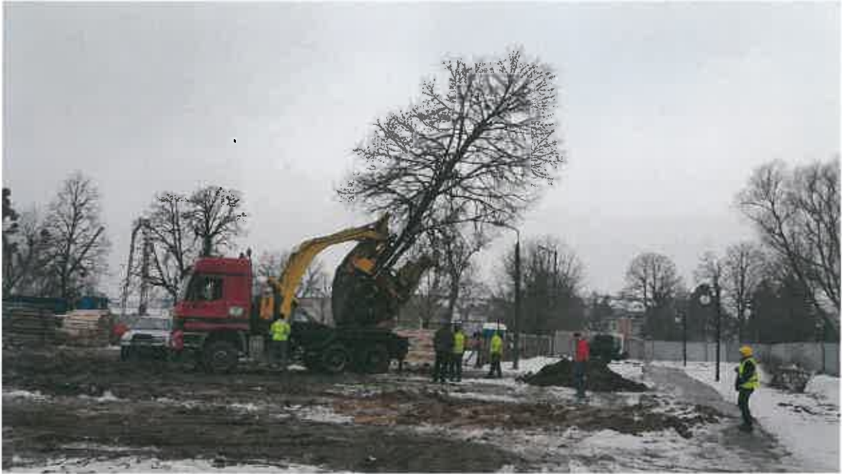
Fot. 7. Przesadzanie drzew
