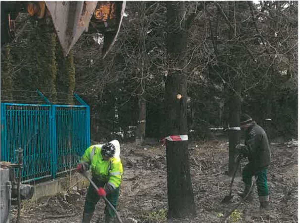
Fot. 8. Przesadzanie drzew
