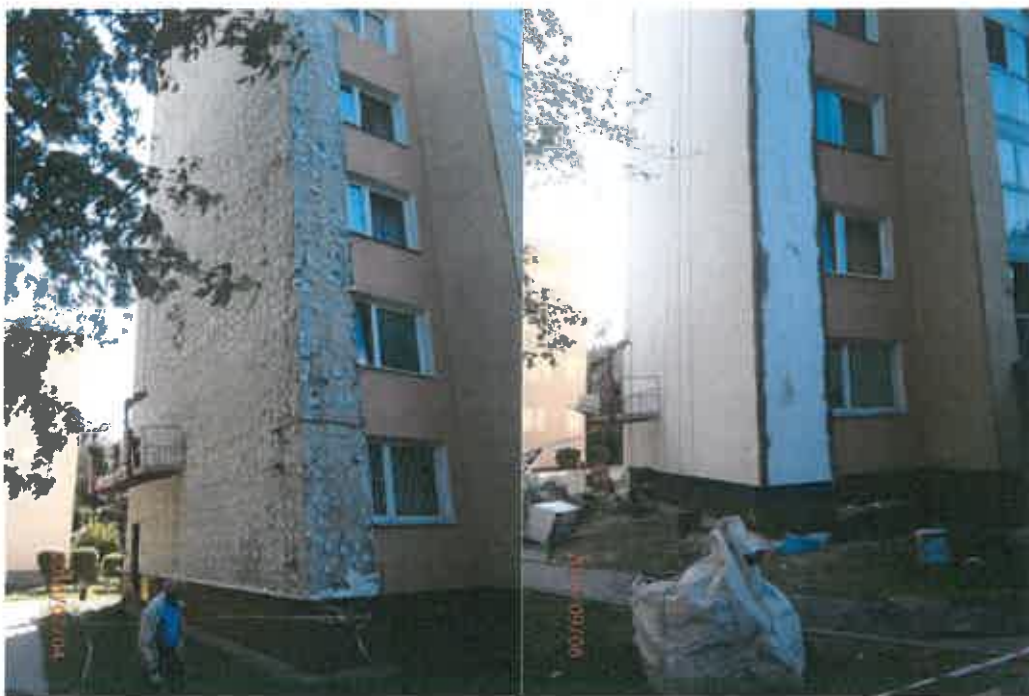
Fot. Elewacja północna budynku Lazurowa 4 po demontażu warstwy docieplenia i po ułożeniu nowej warstwy styropianu.
