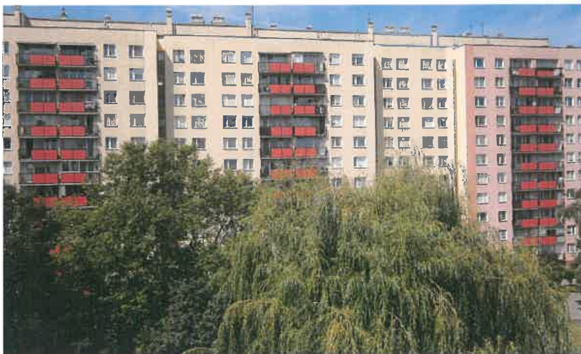
Fot. Lazurowa 4 wyremontowane balustrady balkonowe- elewacja wschodnia
