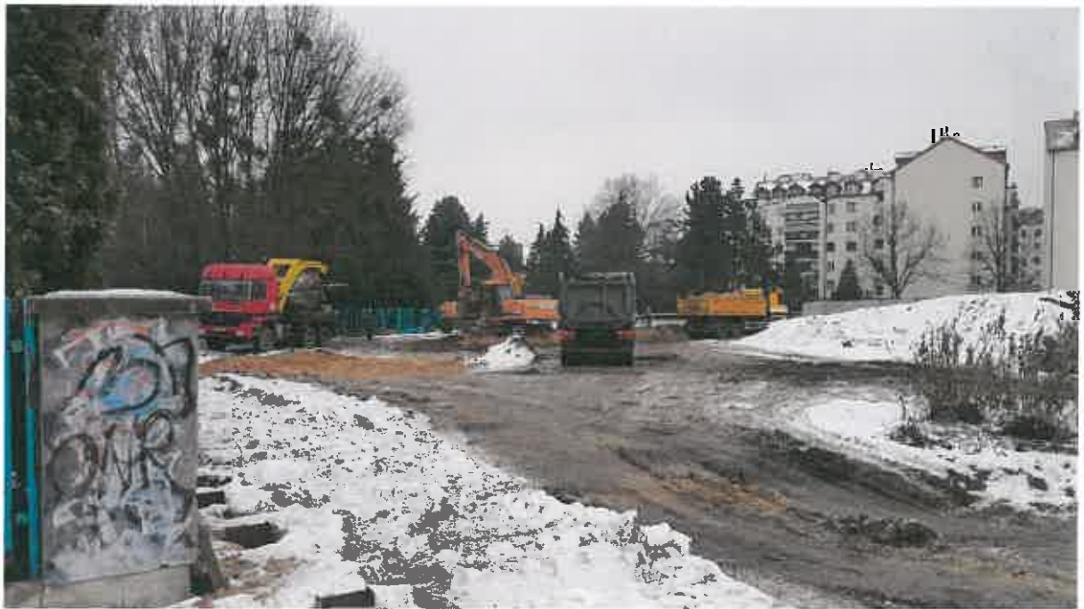
Fot. 2. Roboty ziemne – budynek B1
