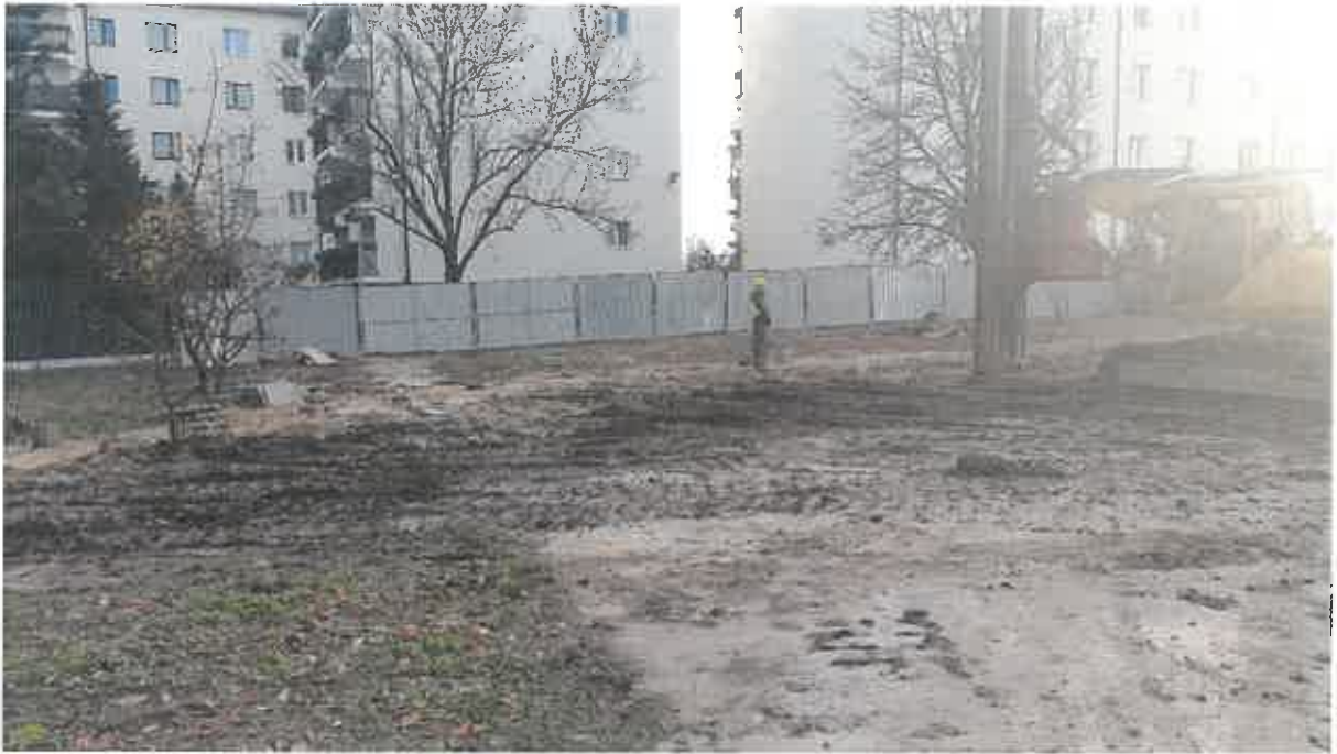
Fot.1. Prace nad zabezpieczeniem wykopu – str południowa – ścianka berlińska
