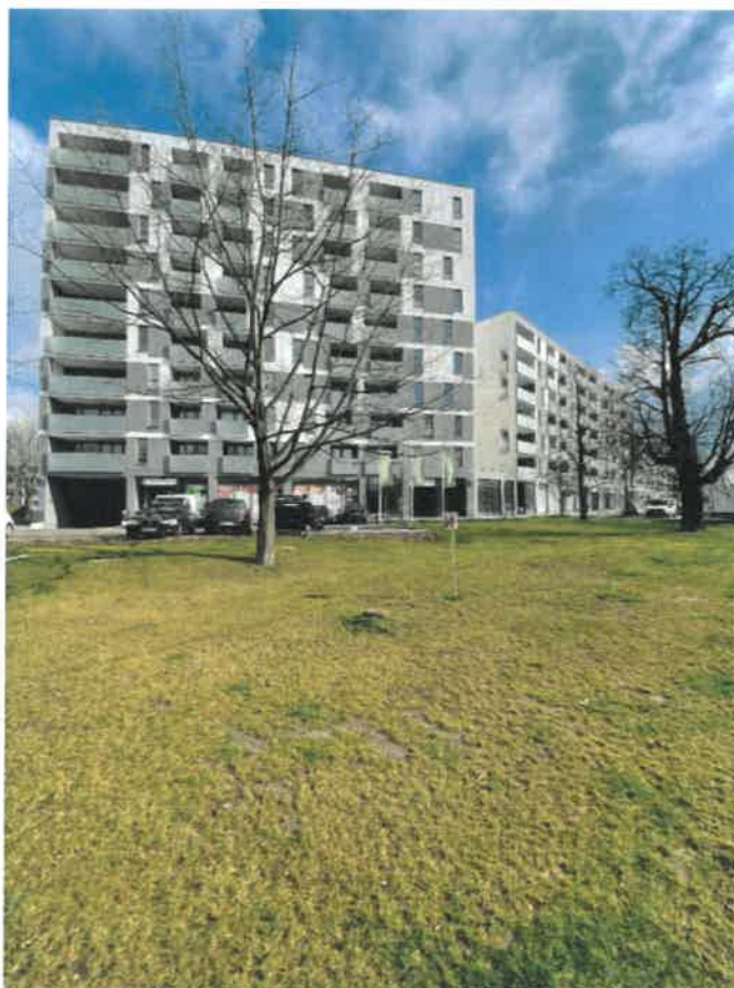
Fot.2. Widok budynku B4 i B3 od strony ul. Szeligowskiej
