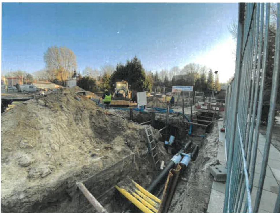
Fot. 8 Usunięcie kolizji sieci ciepłowniczej
