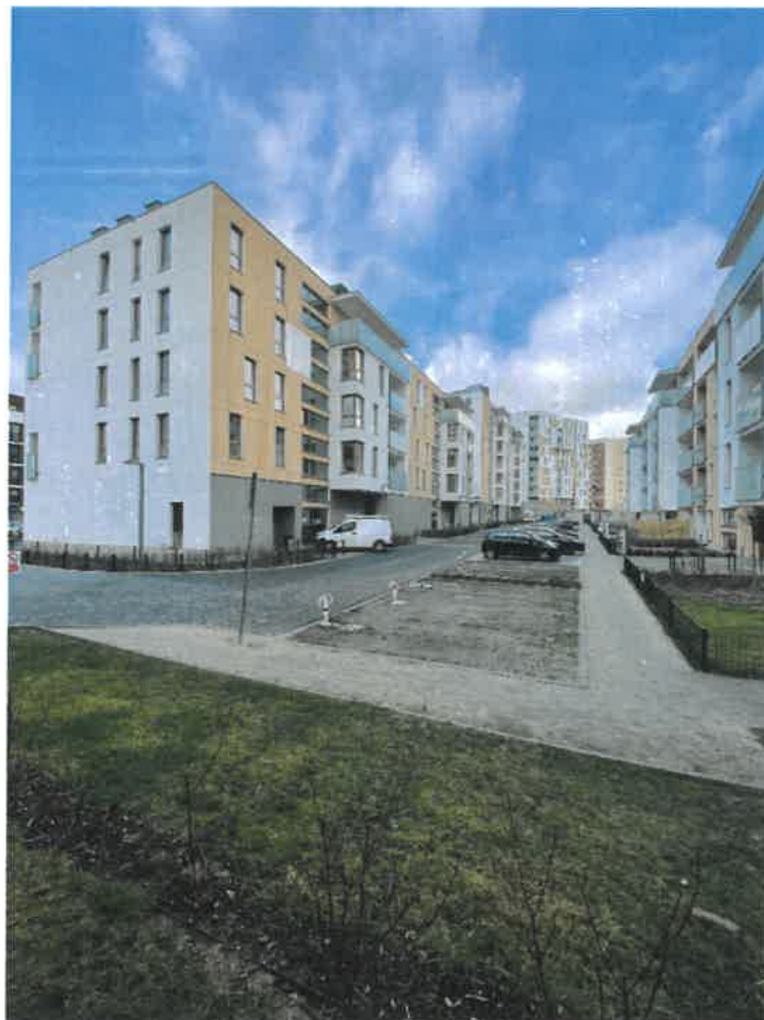
Fot.4. Widok budynków od wewnątrz osiedla
