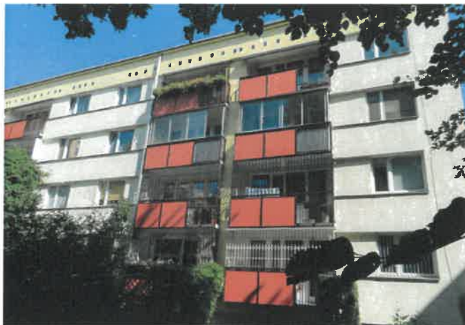
B fot. Wyremontowane balustrady balkonowe w budynku Rozłogi 5
