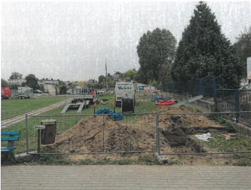
Fot. 11 Usunięcie kolizji sieci energetycznej i teletechnicznej
