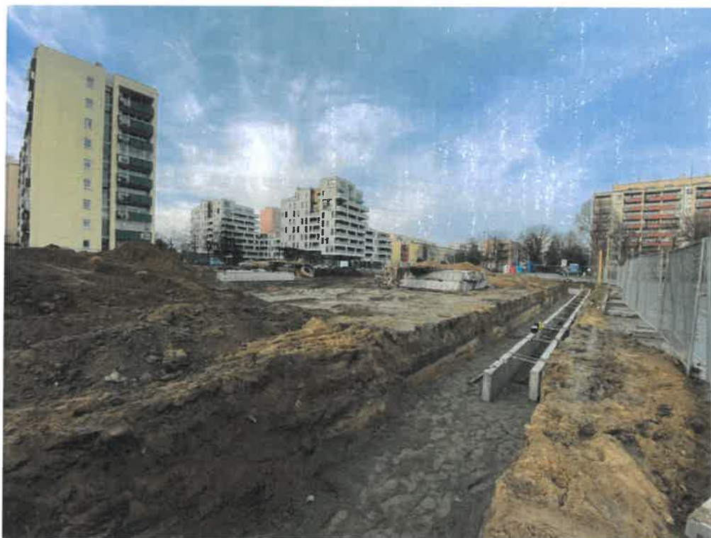
Fot. 13 Wykonanie murków prowadzących pod ściany szczelinowe
