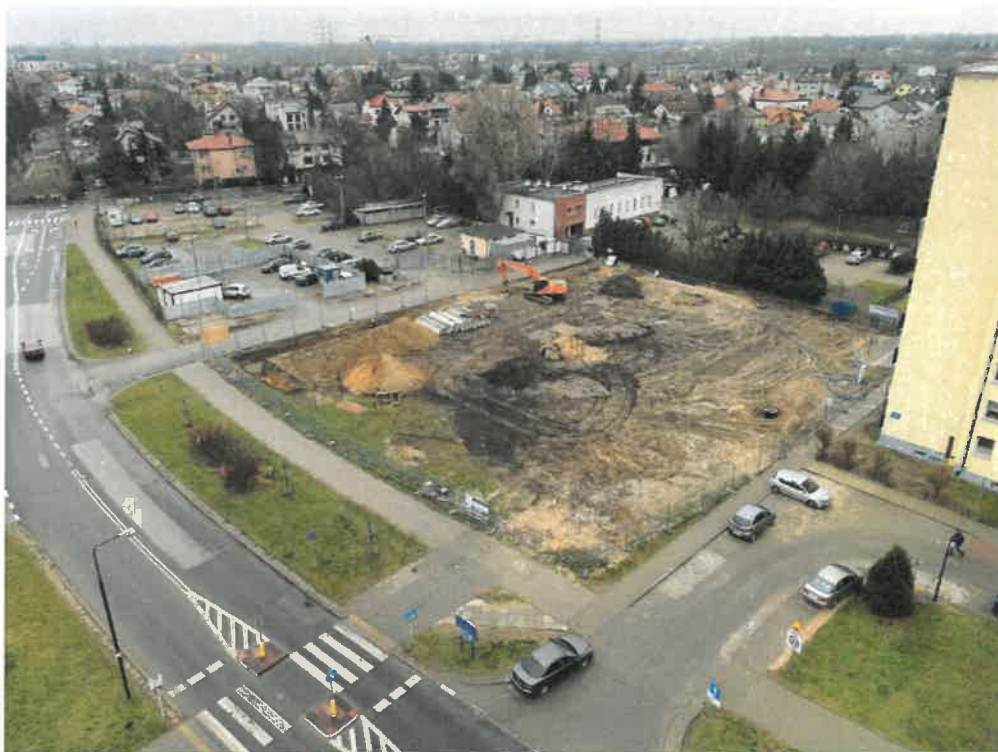
Fot. 12 Widok ogólny placu budowy – po usunięciu kolizji
