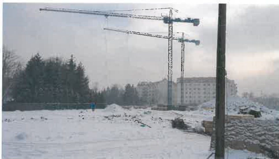
Fot.2. Plac budowy – etap II
