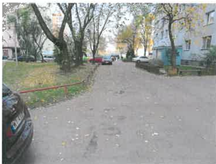
fot. ciąg pieszo-jezdny Siemiatycka 1 przed remontem.
