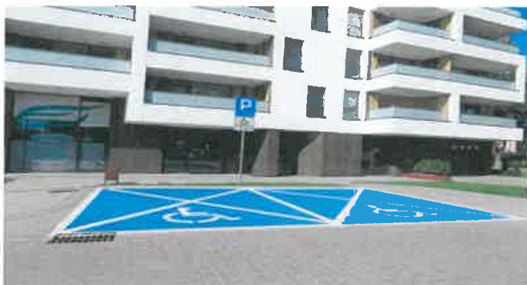
Rys. 2.: Zdjęcie wykonanego oznakowania poziomych miejsc postojowych.
