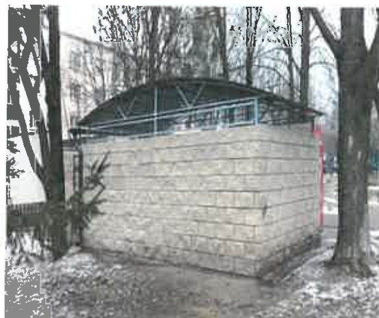
Odbudowana altana śmietnikowa.
