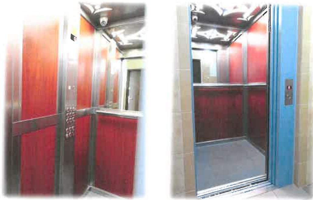
Nowy dźwig w budynku przy ul. Rozłogi 2
