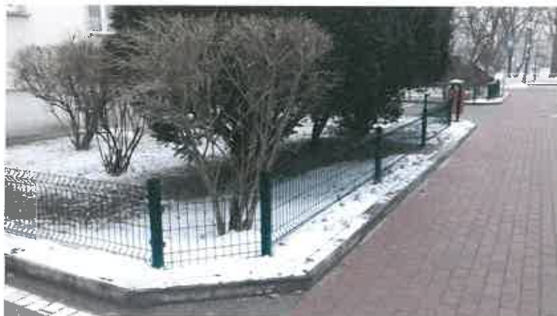
Fot.7: Nowe płotki przed budynkiem Sternicza 131
