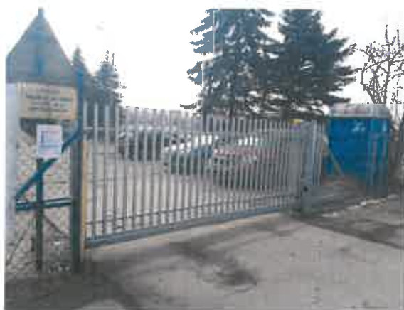
Nowa brama wjazdowa na parking przy Lazurowej 6
