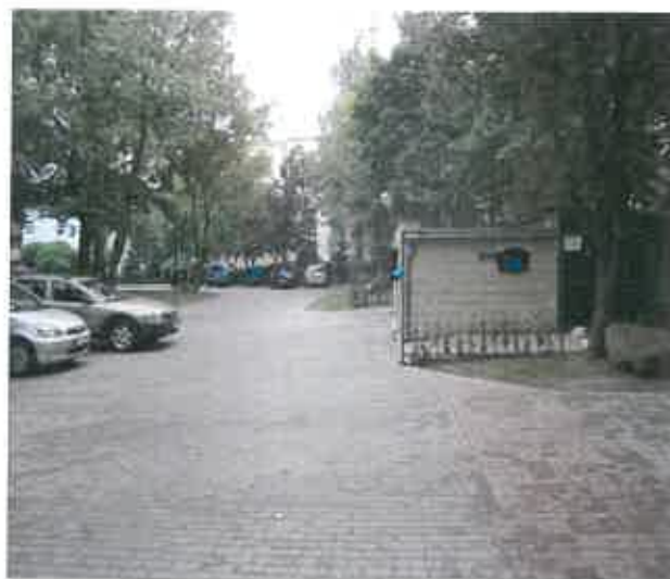
fot. Ten sam ciąg po wykonanym remoncie.
