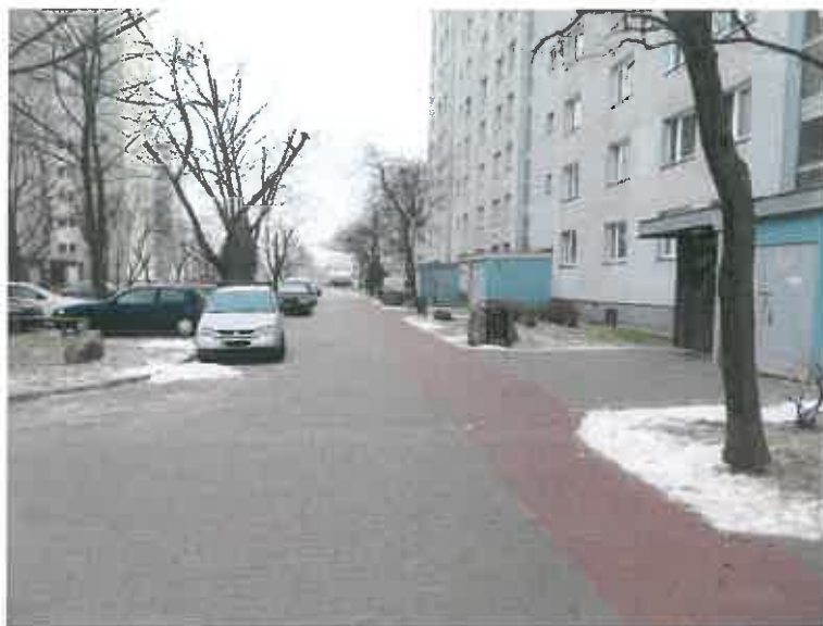
fol. ciąg Siemiatycka 1 po remoncie.
