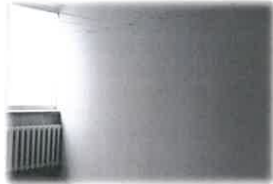
Suszarnia po remoncie
