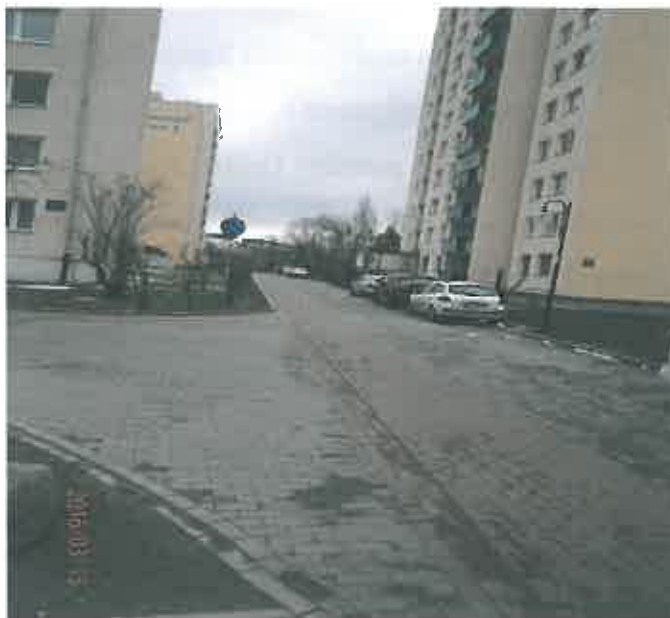
Fot. Ciąg pieszo-jezdny Lazurowa 2 i 2a po remoncie.
