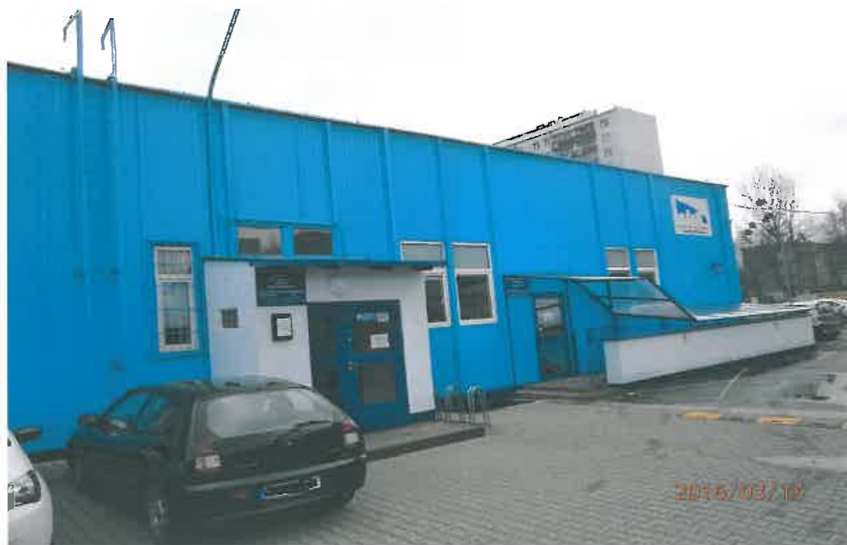
Fot Elewacja wschodnia pawilonu Rozłogi 8 po remoncie
