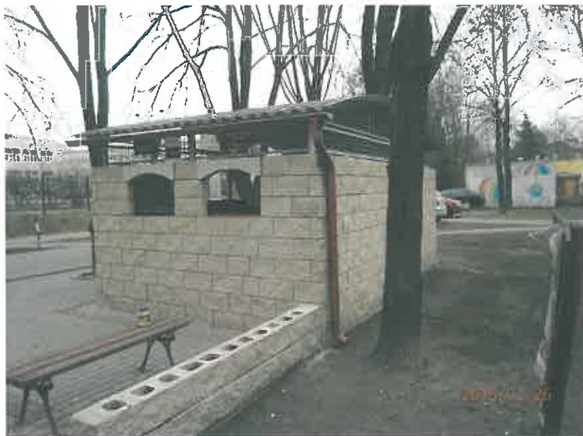
Fot. Altana śmietnikowa przy budynku Rozłogi 4- elewacje zachodnia i południowa
