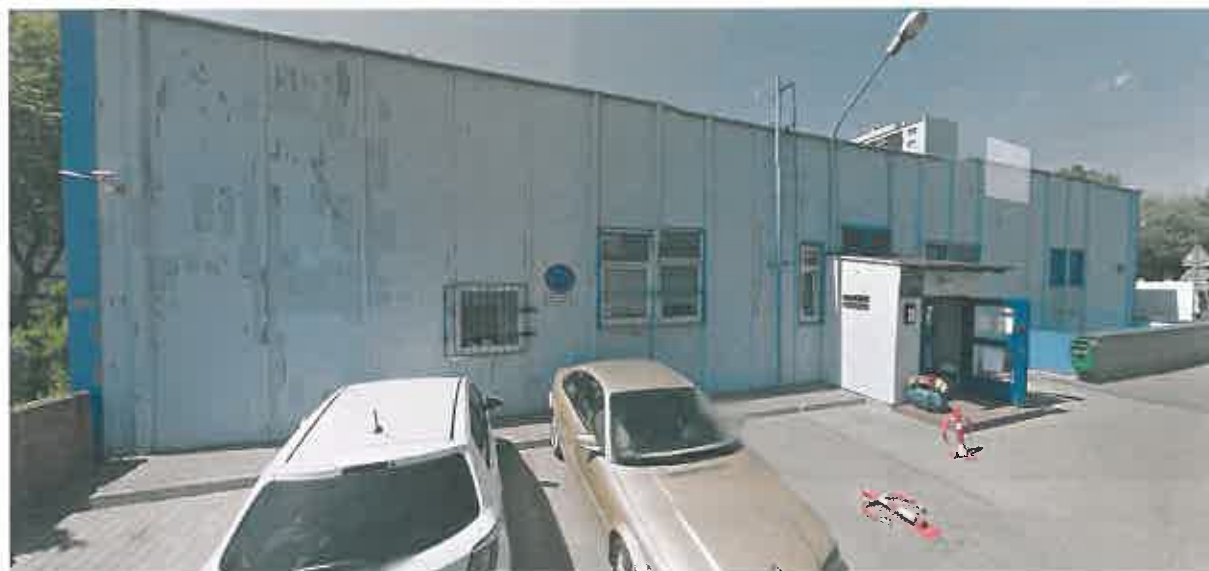
Fot. Elewacja wschodnia pawilonu Rozłogi 8 przed remontem
