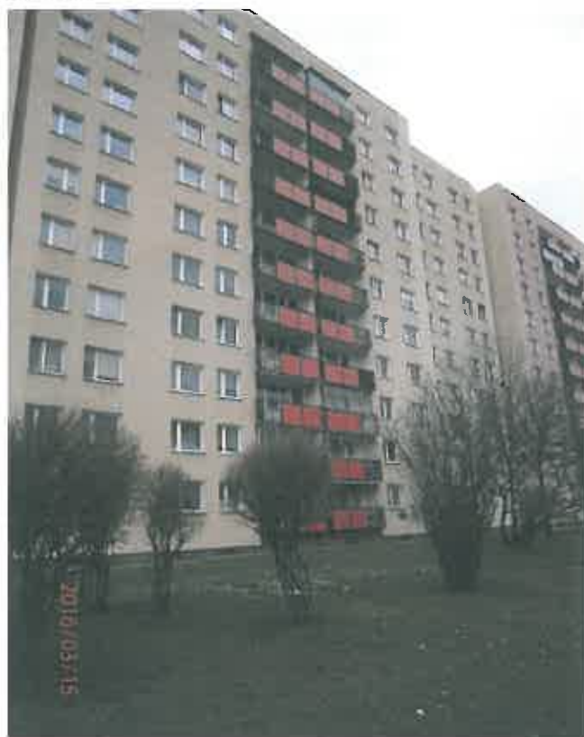
Fot. Wyremontowany pion balkonów w budynku Lazurowa 4.
