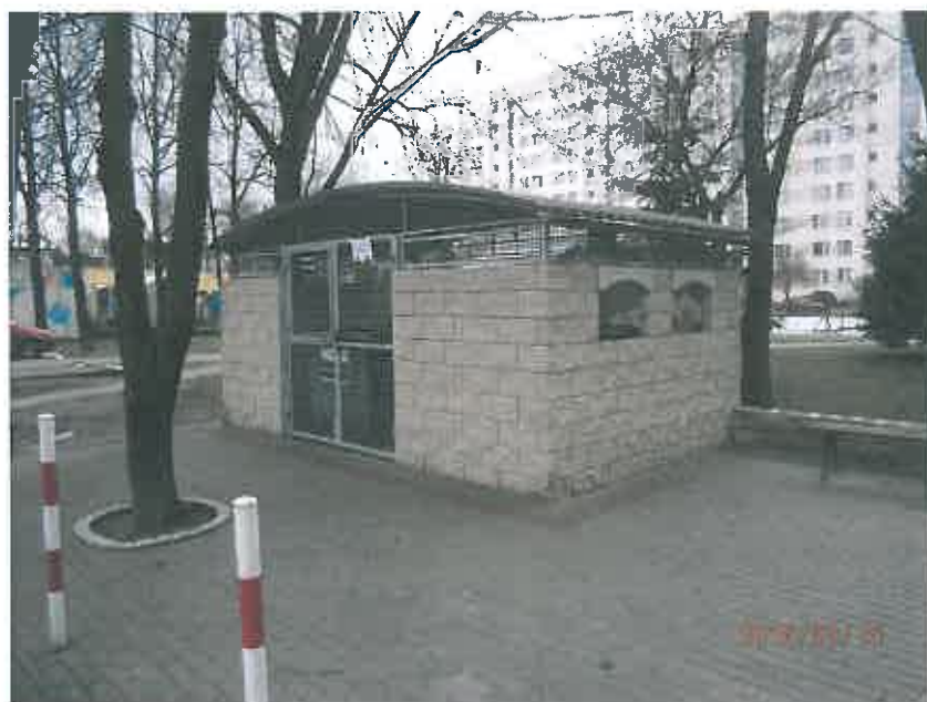
Fot. Altana śmietnikowa przy budynku Rozłogi 4- elewacje północna i zachodnia
