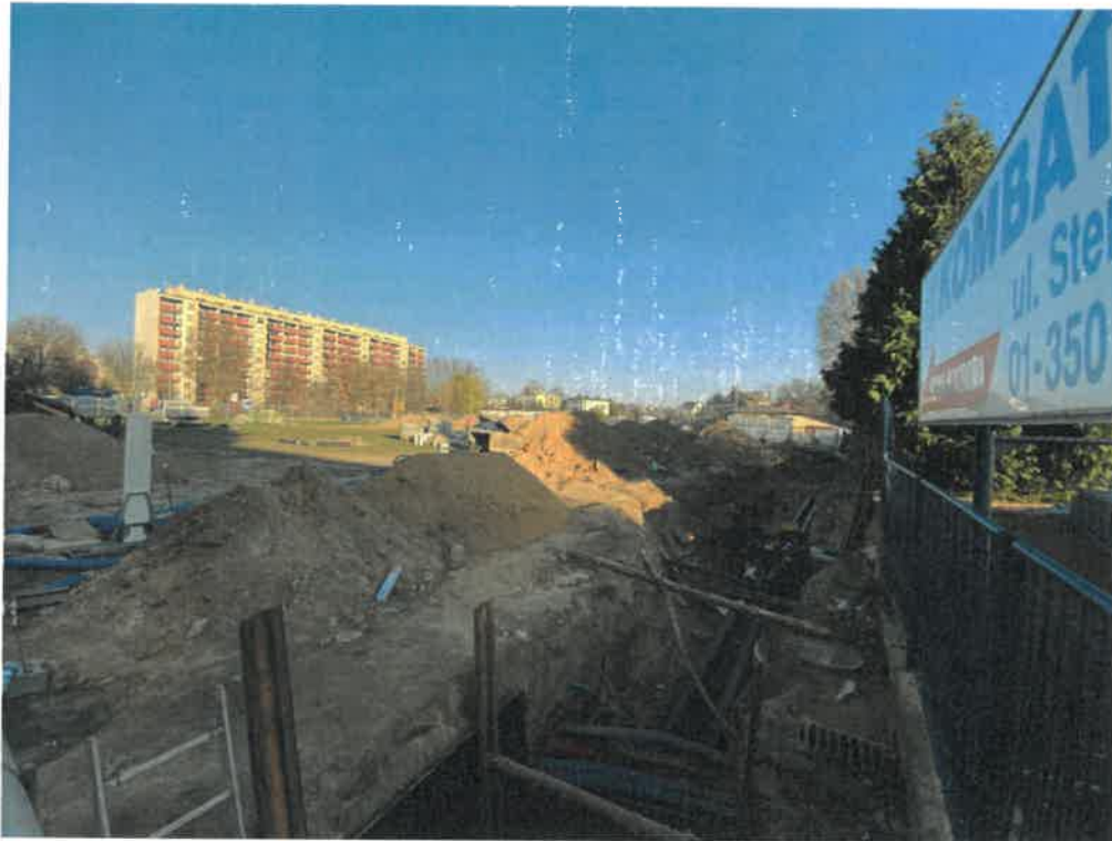
Fot. 9 Usunięcie kolizji sieci ciepłowniczej
