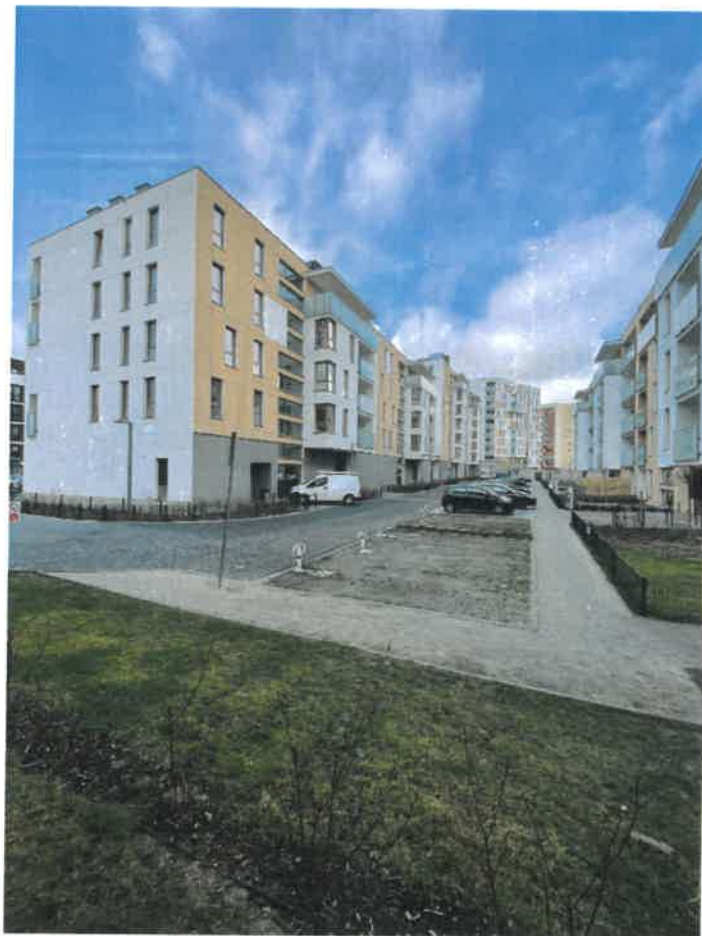
Fot.4. Widok budynków od wewnątrz osiedla
