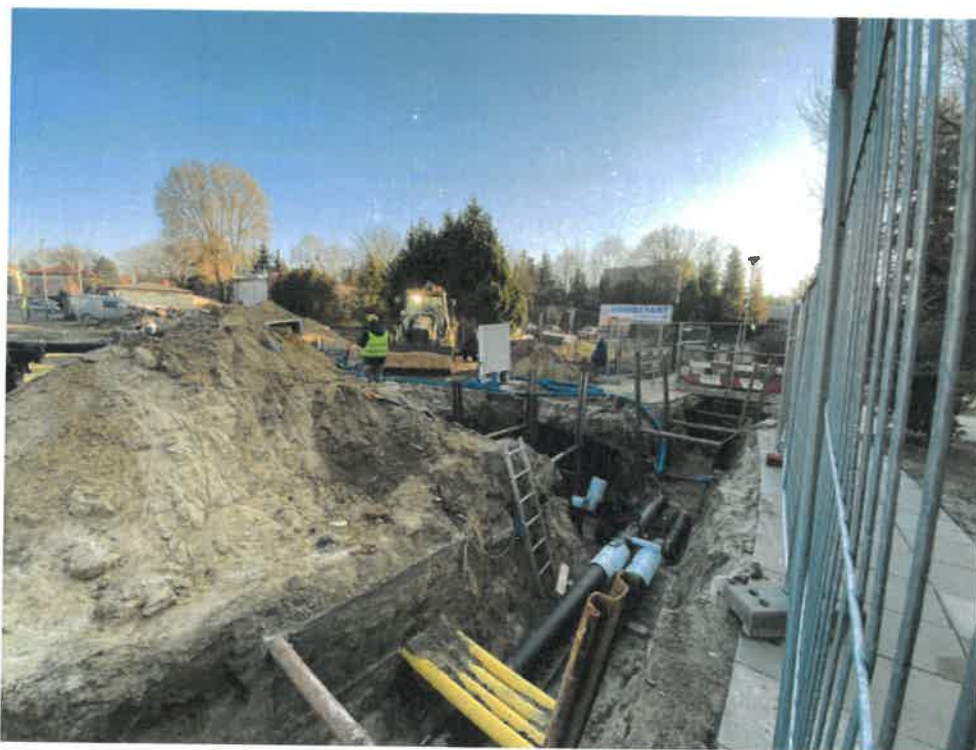
Fot. 8 Usunięcie kolizji sieci ciepłowniczej
