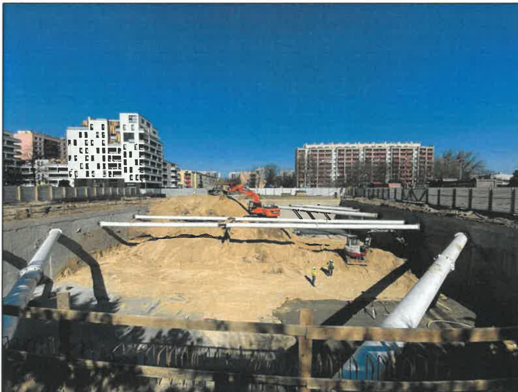
Fot. 12 Wykop pod garaż podziemny – ostatnia faza realizacji
