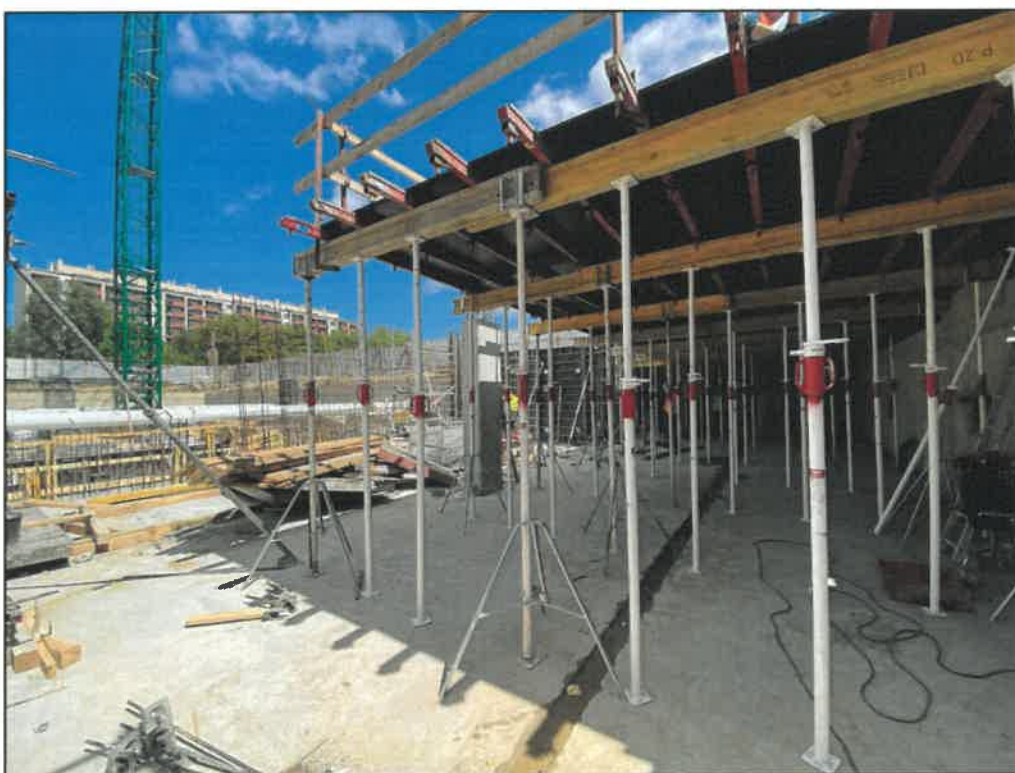
Fot. 15. Wykonanie stropu poziom 0
