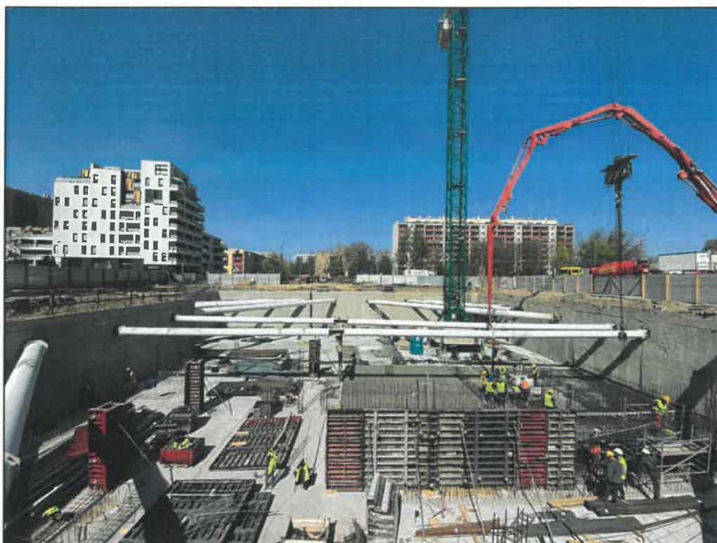
Fot. 15. Wykonanie pierwszych ścian i słupów konstrukcyjnych
