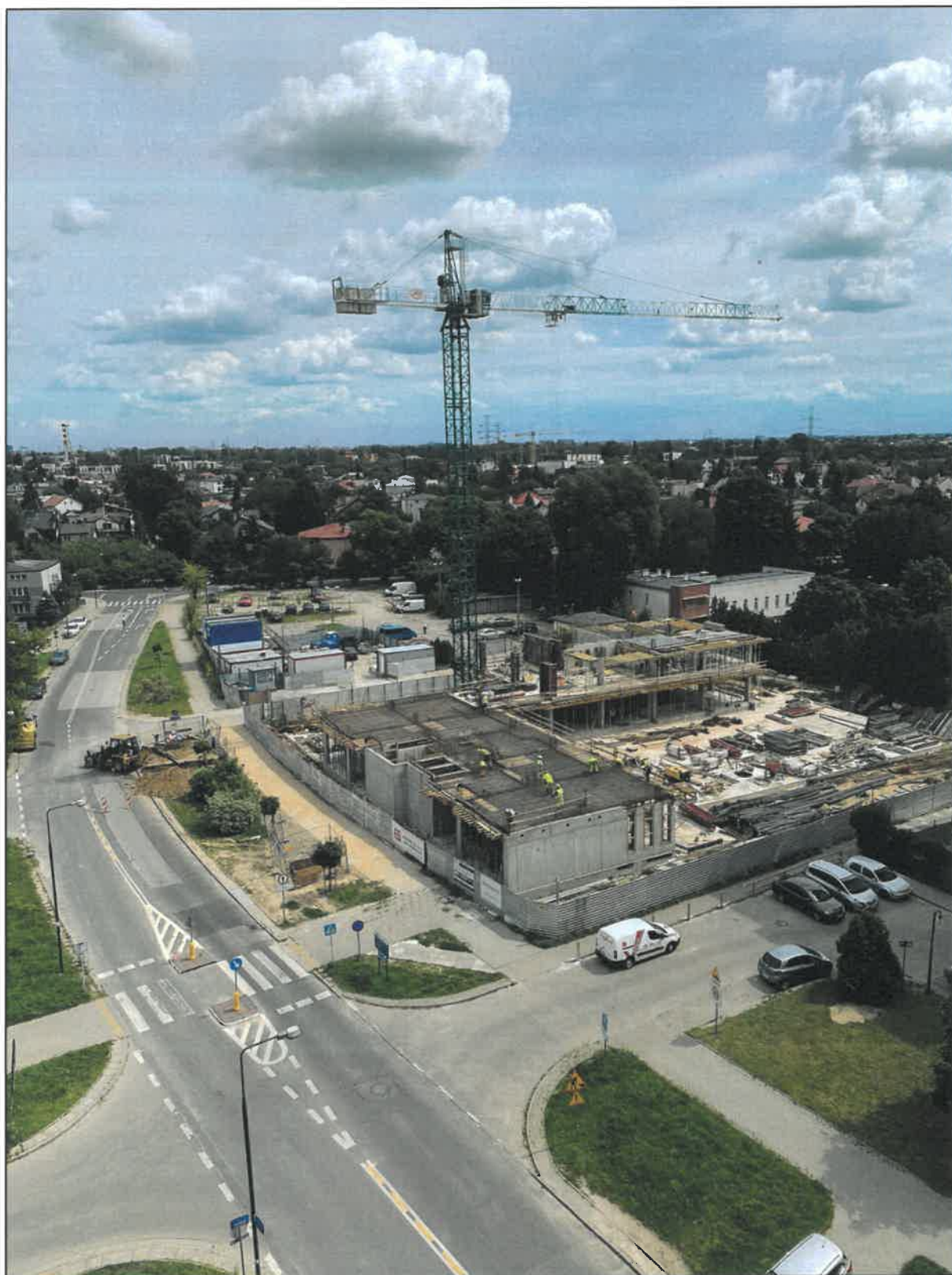
Fot. 15. Widok ogólny placu budowy
