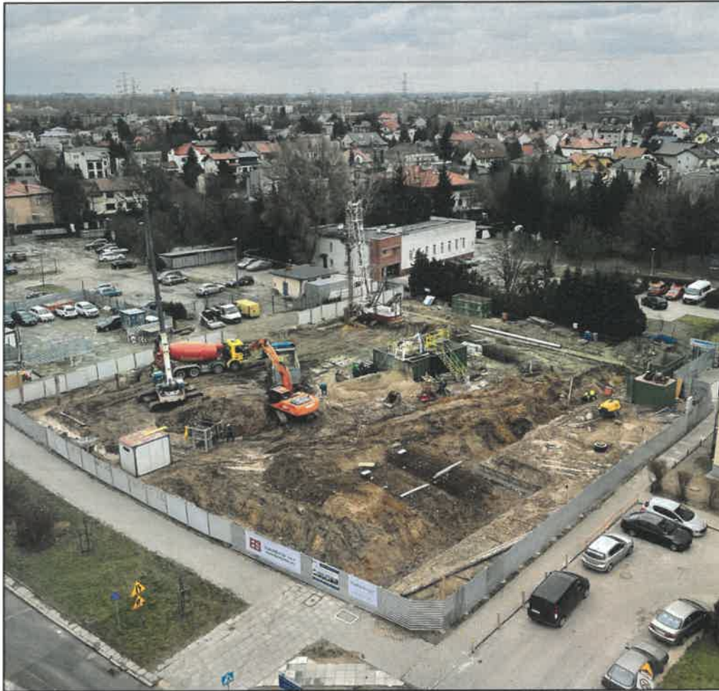
Fot. 10 i 11 - Rozpoczęcie wykopów pod garaże podziemne
