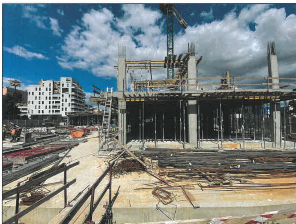
Fot. 15. Roboty żelbetowe - roboty żelbetowe kondygnacji 1 i 2
