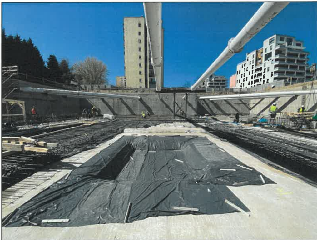
Fot. 14. Wykonanie zbrojenia na poziomie – 2 garażu
