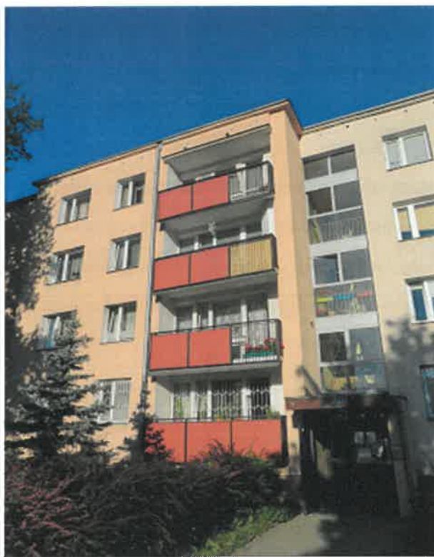
fot. Wyremontowane balustrady balkonowe w budynku Rozłogi 4- elewacja wschodnia przy kl. I
