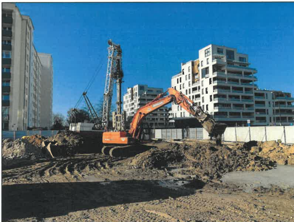
Fot. 9 Wykonywanie ścian szczelinowych – ostatnia faza realizacji
