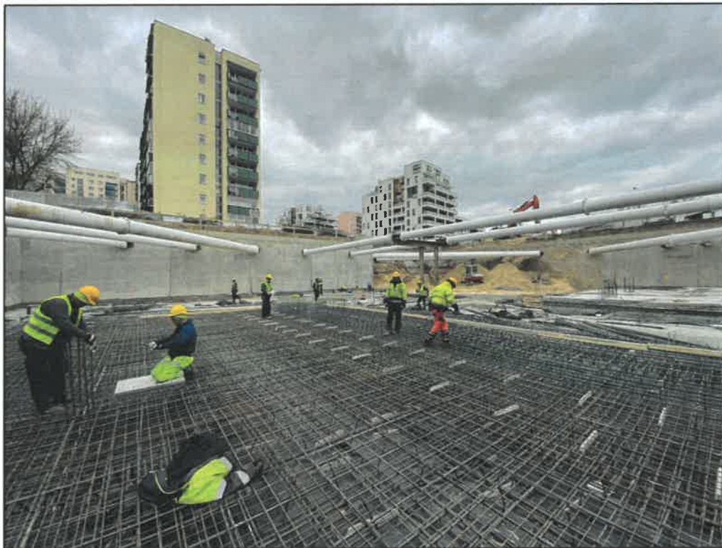
Fot. 13 Wykonywanie zbrojenia na poziomie – 2 garażu
