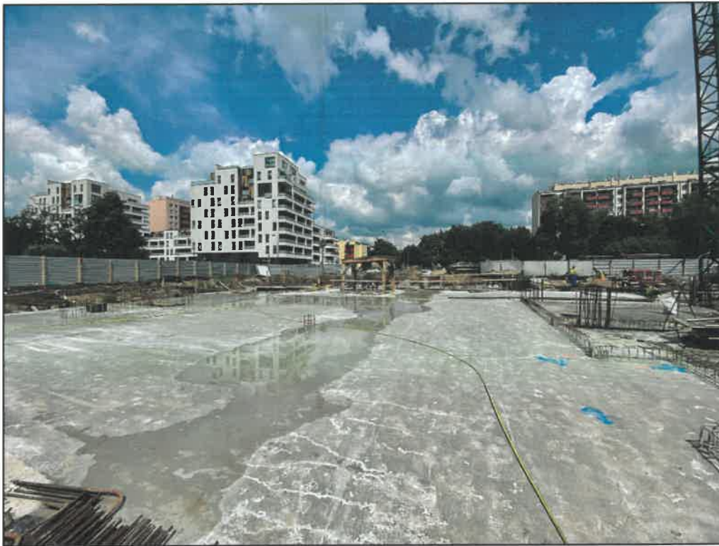
Fot. 15. Gotowa płyta stropowa na poziomie 0
