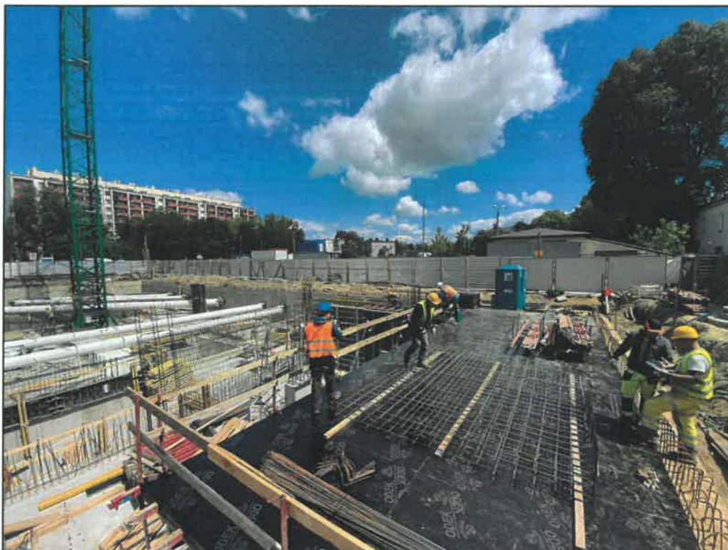
Fot. 15. Roboty żelbetowe na poziomie 0
