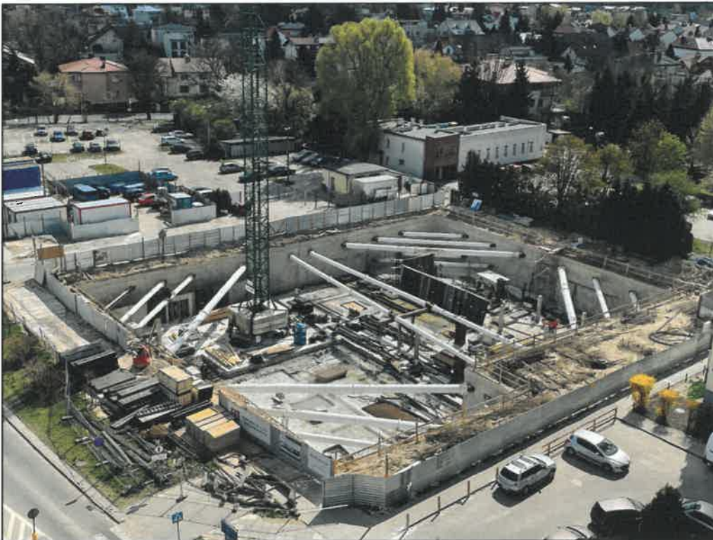
Fot. 15. Widok ogólny placu budowy
