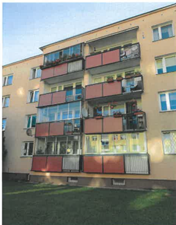
fot. Wyremontowane balustrady balkonowe w budynku Rozłogi 4- elewacja zachodnia
