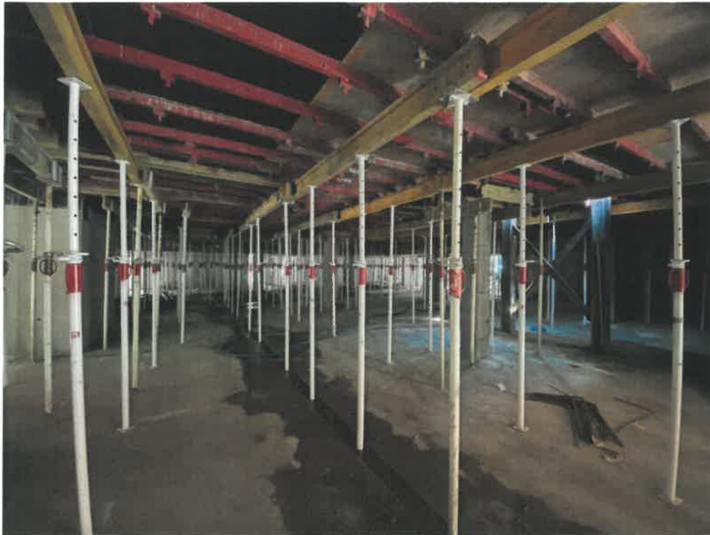
Fot. 15. Wykonanie stropu garażu podziemnego
