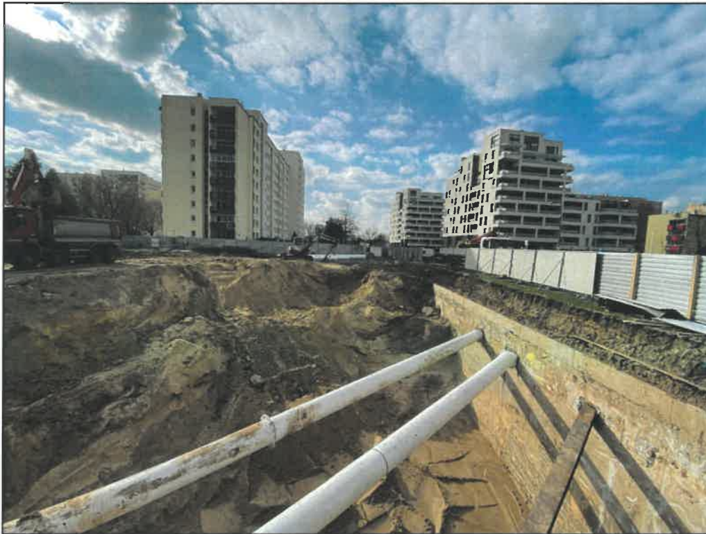
Fot. 11 Montaż pierwszych rozpór zabezpieczających ściany szczelinowe na czas wykopów
