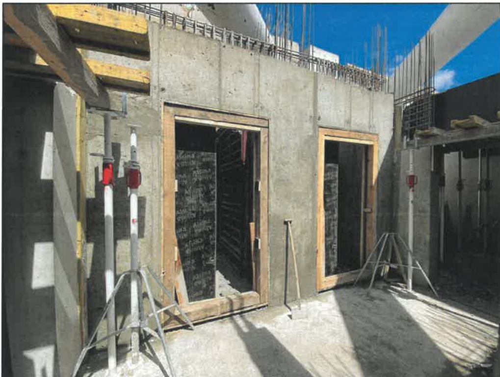
Fot. 15. Wykonanie wejść do szybów windowych na poziomie - 2
