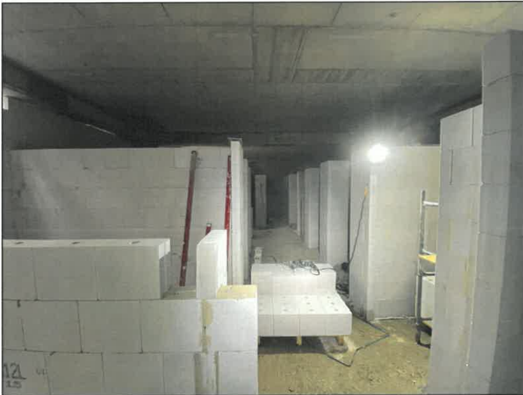
Fot. 15. Roboty murarskie - ściany działowe komórek lokatorskich
