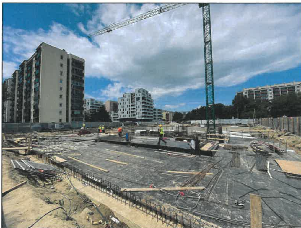
Fot. 15. Roboty żelbetowe na poziomie 0
