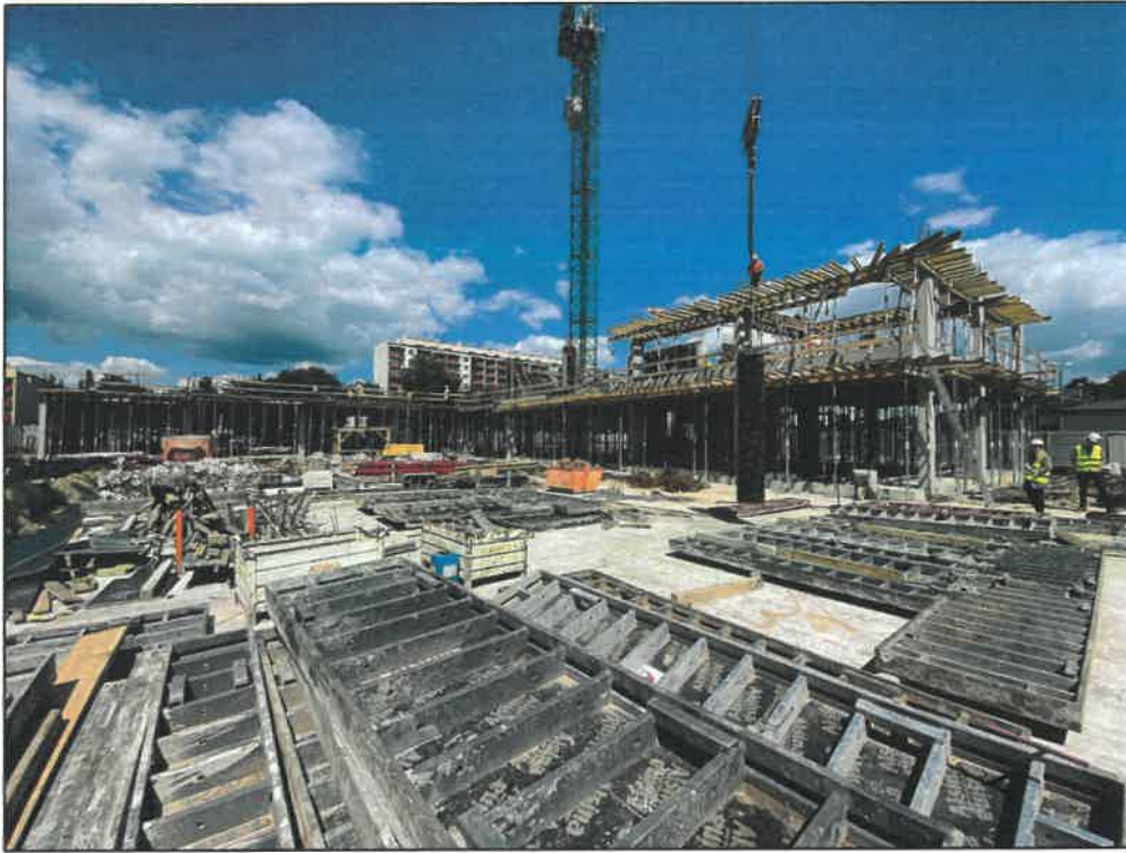
Fot. 15. Roboty żelbetowe kondygnacji 1 i 2
