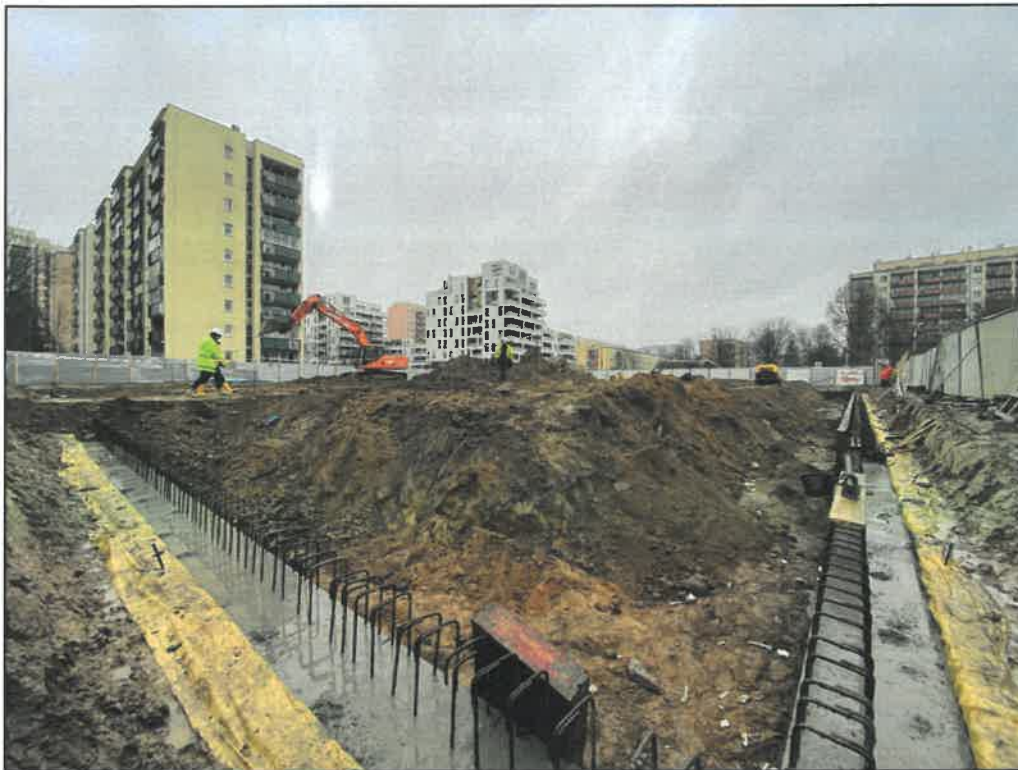
Fot. 9 Wykonywanie ścian szczelinowych – ostatnia faza realizacji
