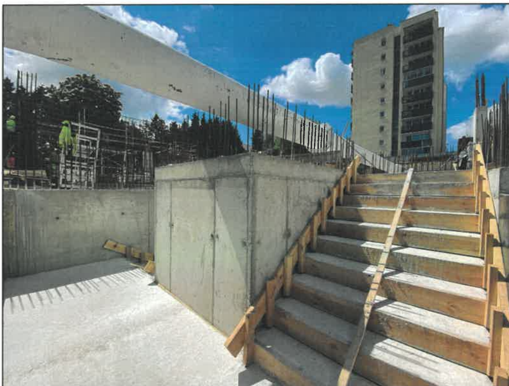
Fot. 15. Wykonanie schodów klatki schodowej z poziomu -2 na -1
