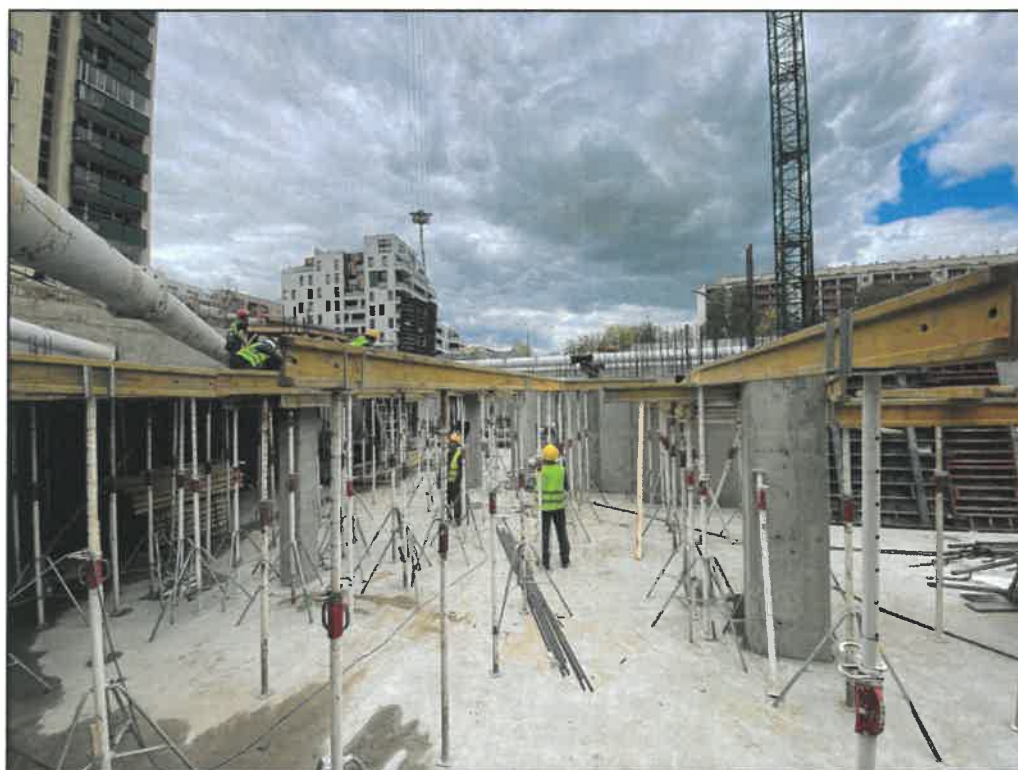
Fot. 15. Roboty żelbetowe na poziomie - 2
