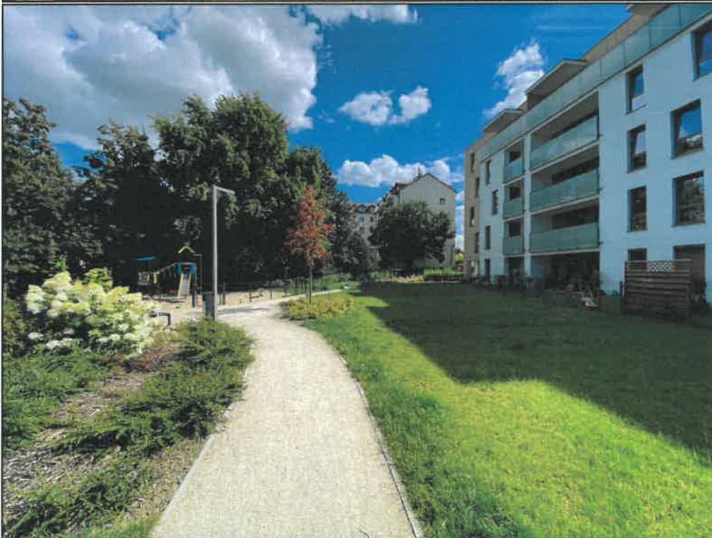
Fot.3 i 4 - Widok budynku B1 od strony Domu Kombatanta
