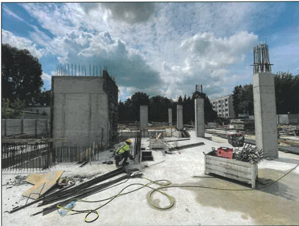
Fot. 15. Roboty żelbetowe - pierwsze słupy i szyby windowy nad poziomem 0
