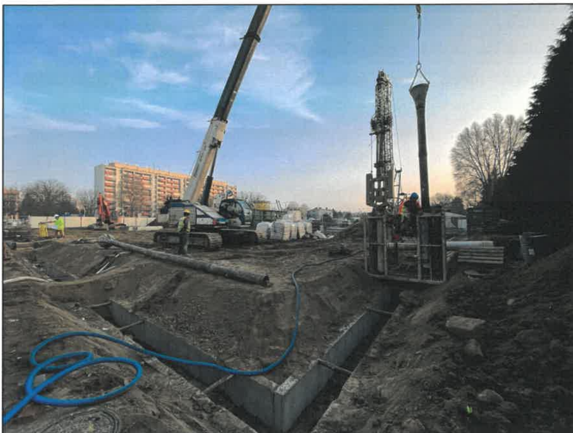
Fot. 8 Wykonywanie ścian szczelinowych
