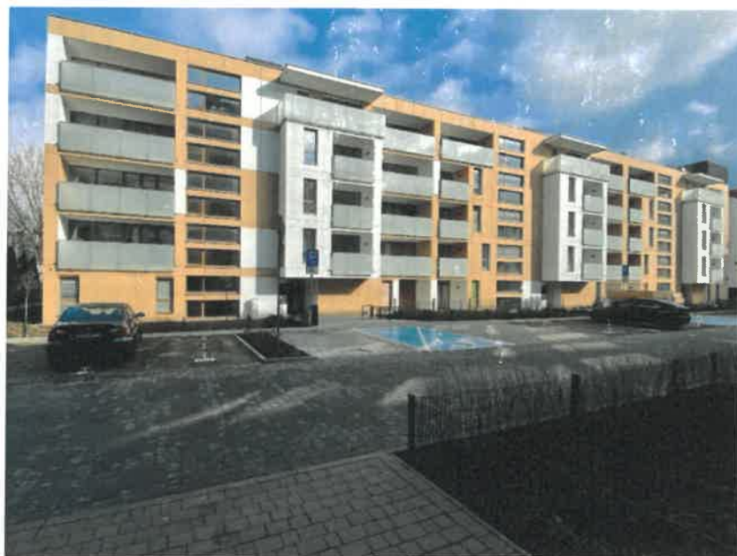
Fot.5. Widok budynków od wewnątrz osiedla c.d.
