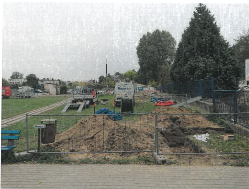
Fot. 11 Usunięcie kolizji sieci energetycznej i teletechnicznej
