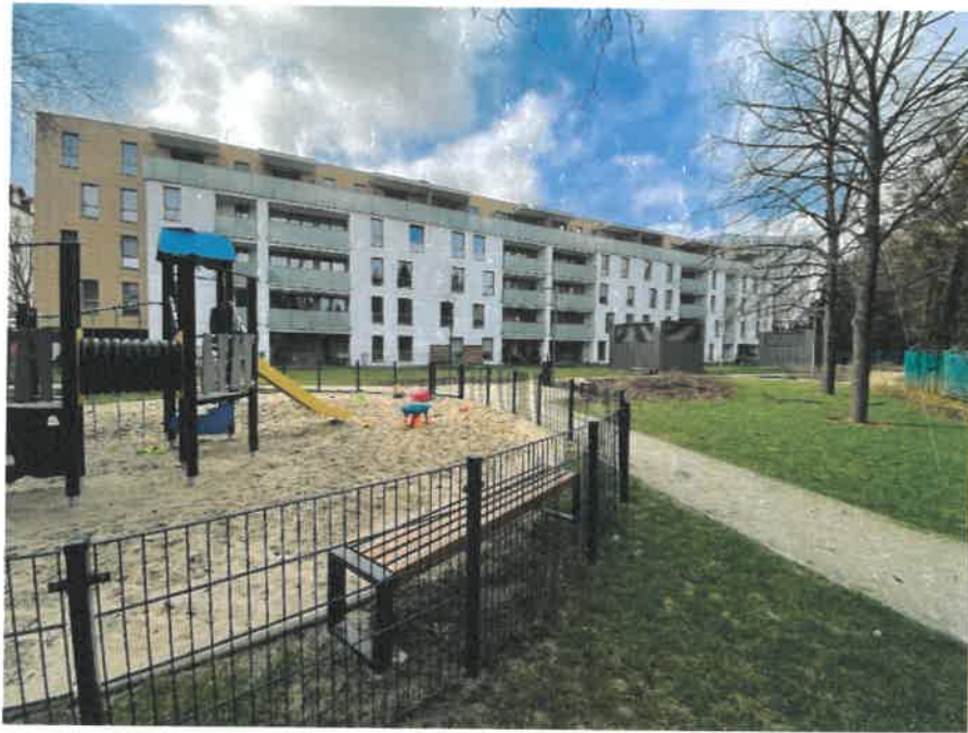
Fot.3. Widok budynku B1 od strony Domu Kombatanta
