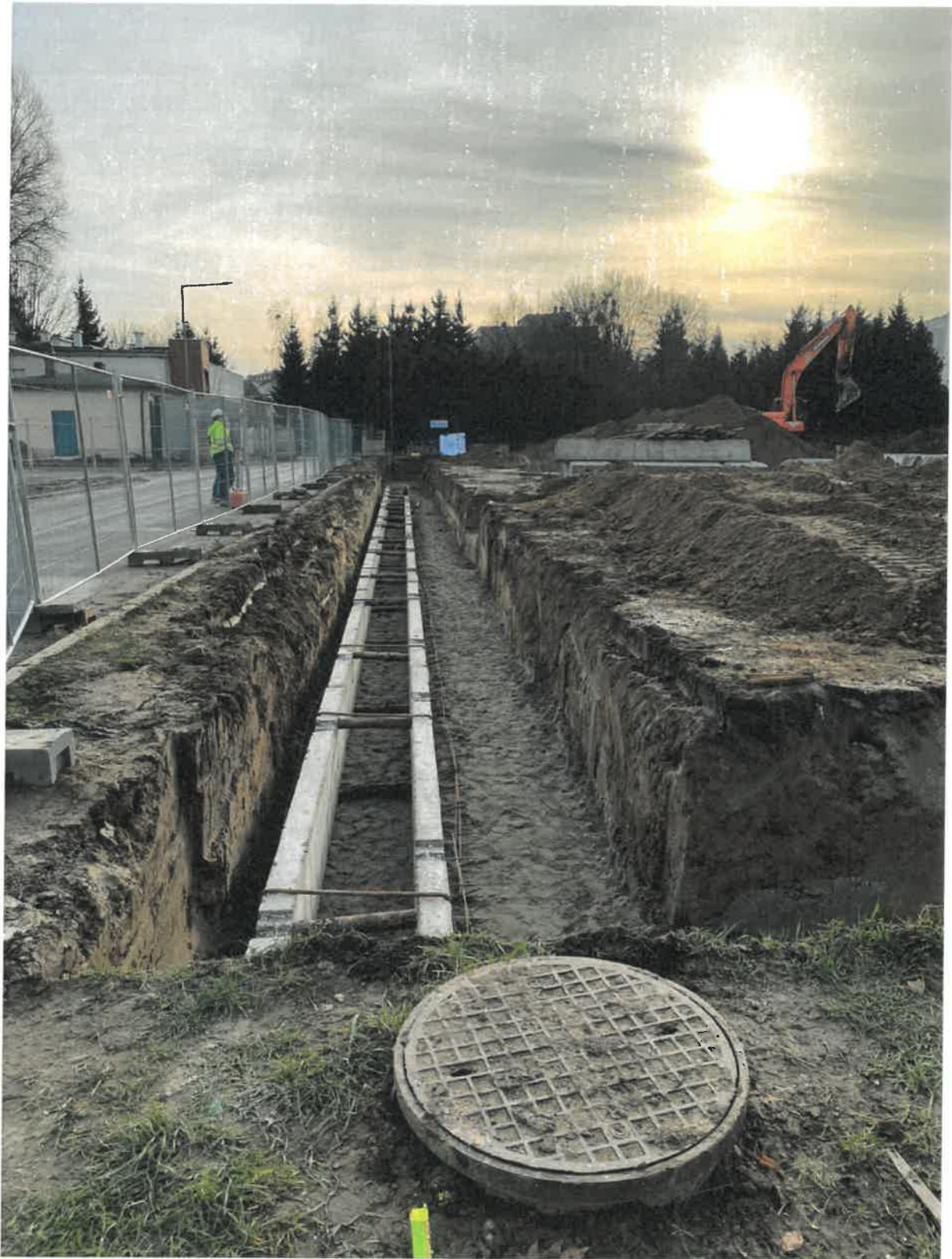
Fot. 15. Wykonanie murków prowadzących wzdłuż drogi dojazdowej do DPS Kombatant
