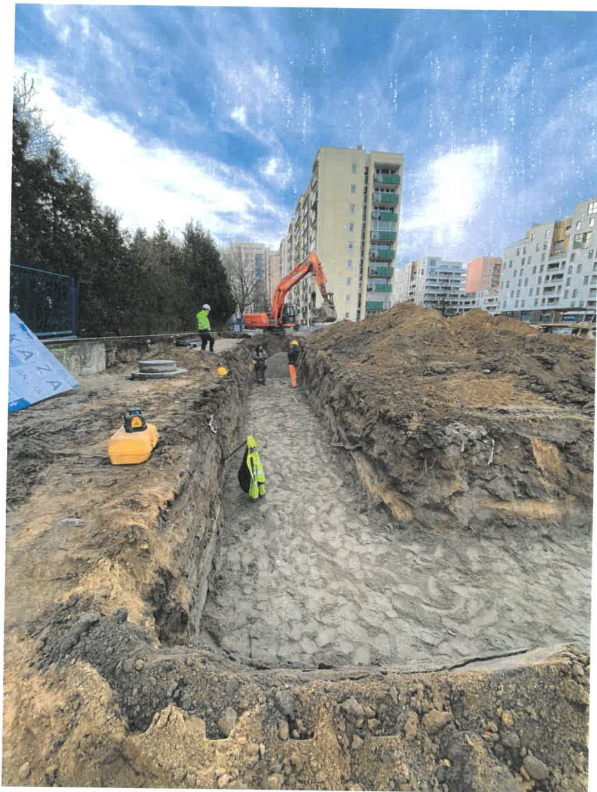
Fot. 14. Wykonanie podbudowy pod murki prowadzące od strony DPS Kombatant
