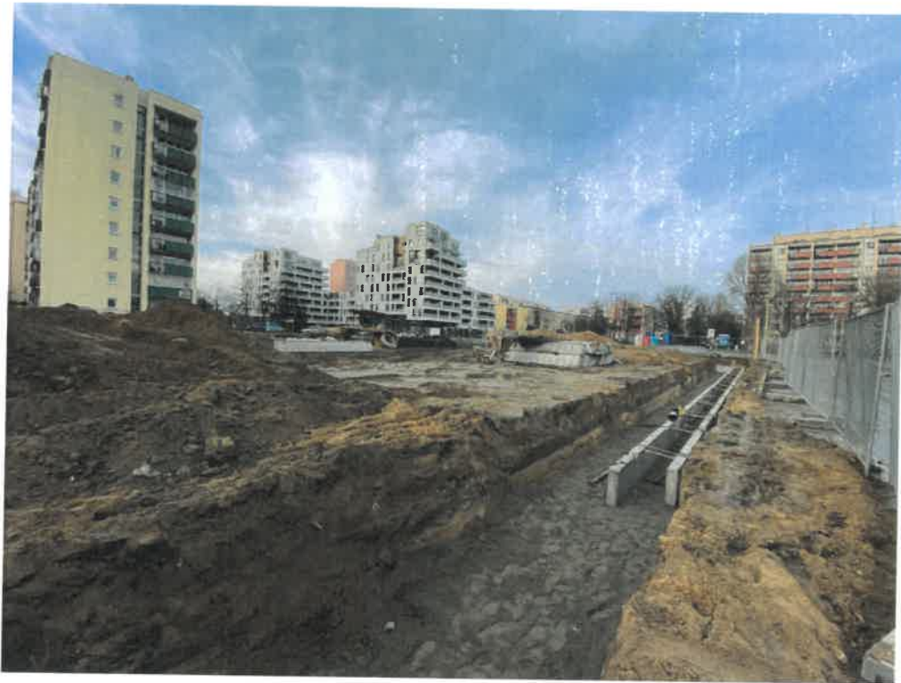
Fot. 13 Wykonanie murków prowadzących pod ściany szczelinowe
