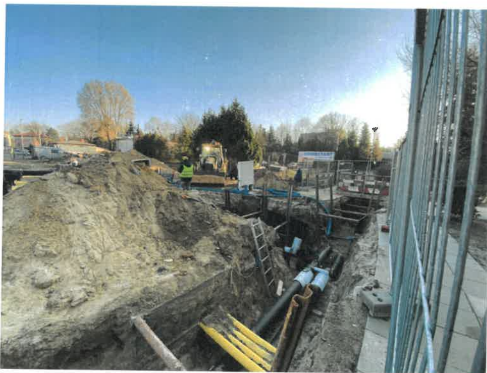
Fot. 8 Usunięcie kolizji sieci ciepłowniczej
