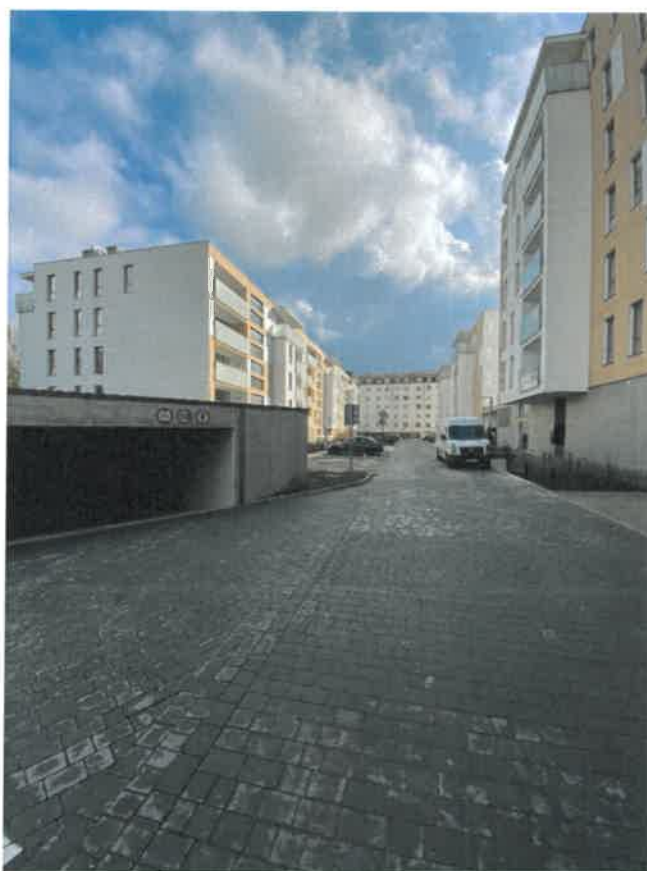
Fot.6. Widok budynków od wewnątrz osiedla c.d.
