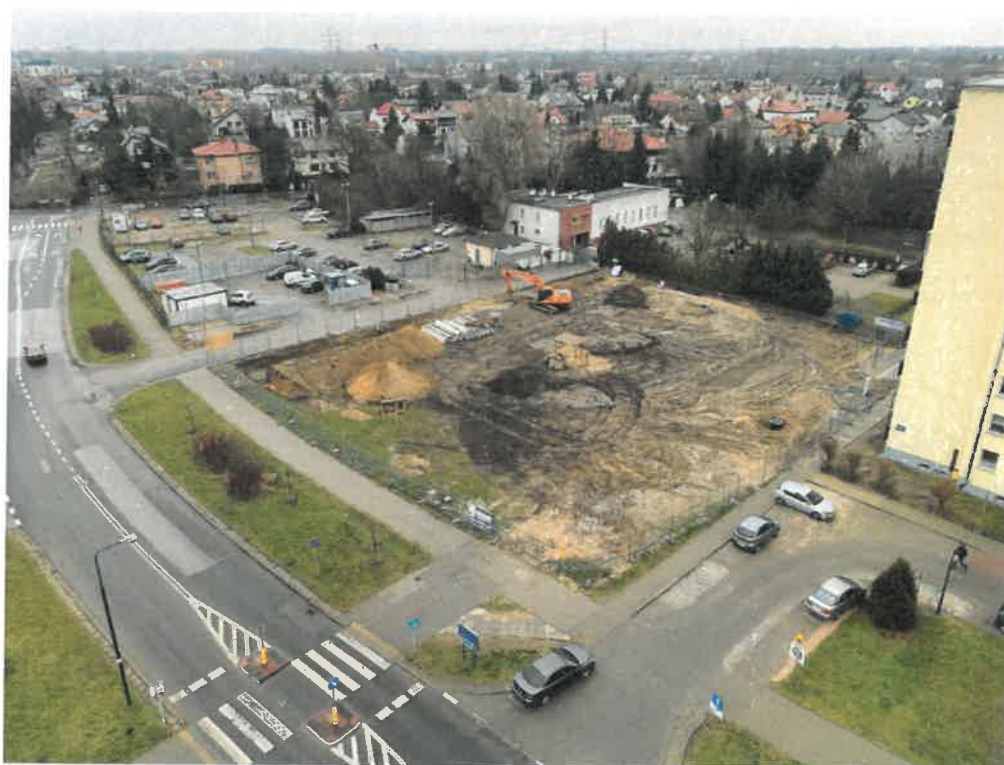
Fot. 12 Widok ogólny placu budowy – po usunięciu kolizji
