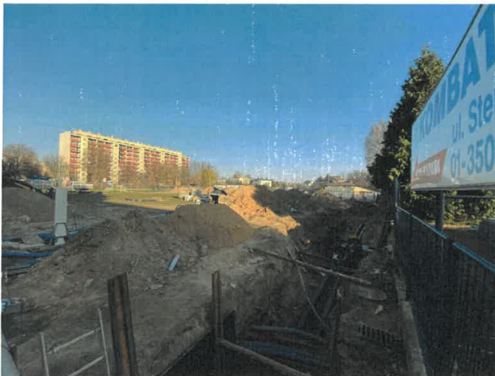
Fot. 9 Usunięcie kolizji sieci ciepłowniczej
