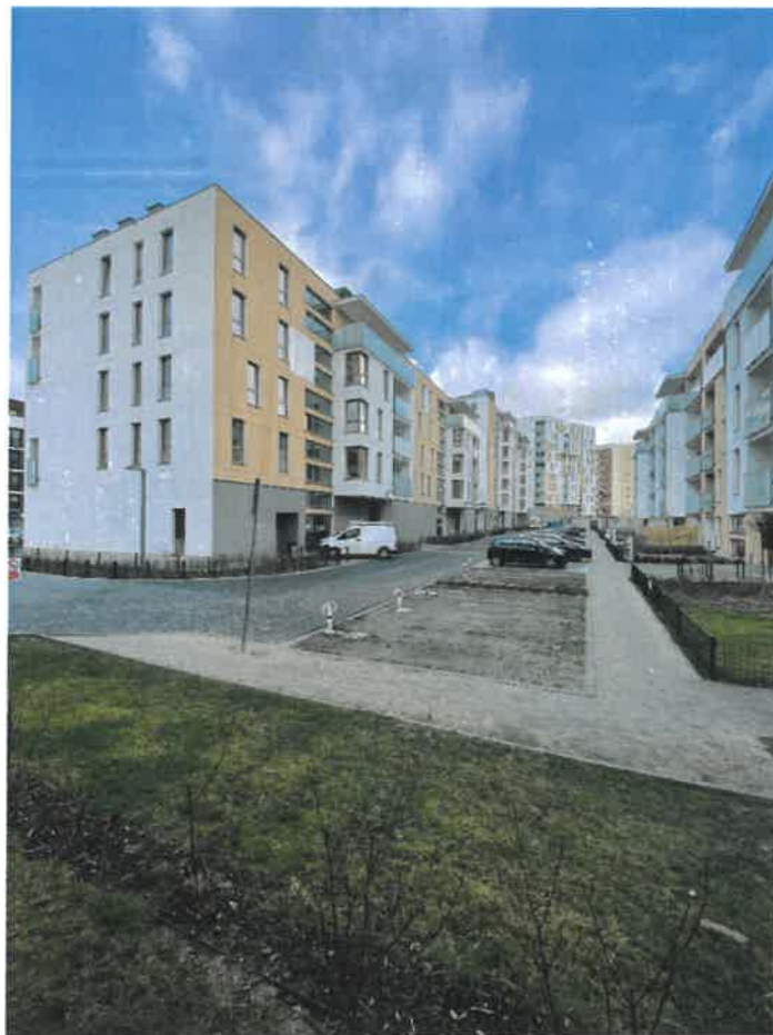
Fot.4. Widok budynków od wewnątrz osiedla
