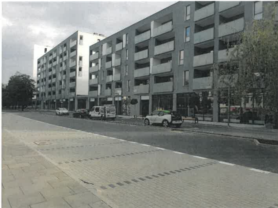
Fot.2. Widok budynku B2 i B3 od strony ul. Szeligowskiej
