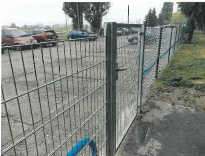
Fot.: nowe ogrodzenie parkingu Lazurowa 6
