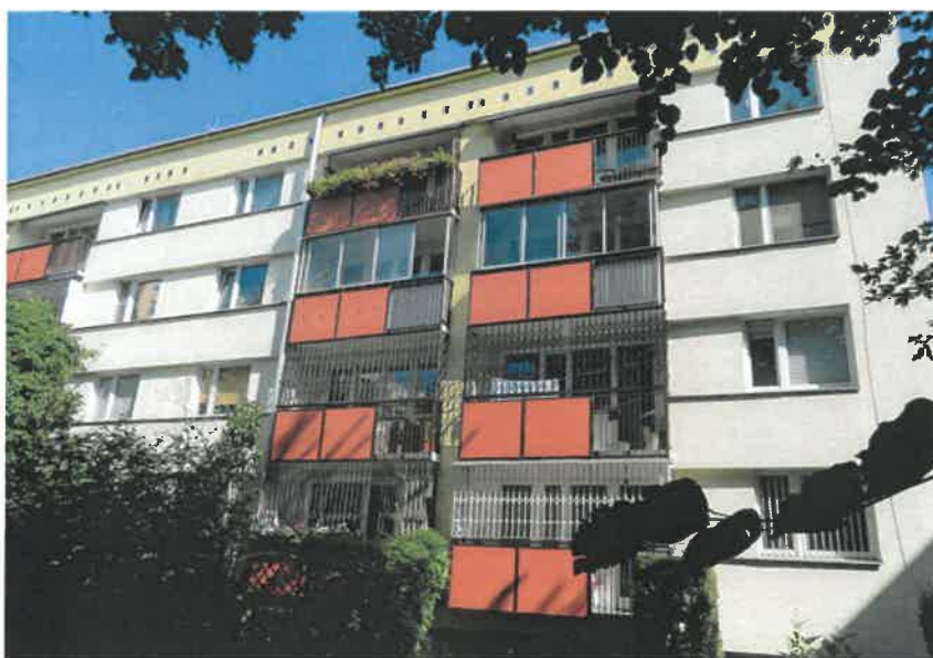
fot. Wyremontowane balustrady balkonowe w budynku Rozłogi 5
