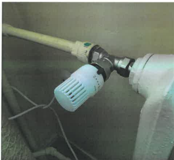
fot. Wymieniony zawór przy grzejniku podczas prac regulacji instalacji c.o. w budynku Siemiatycka 1
