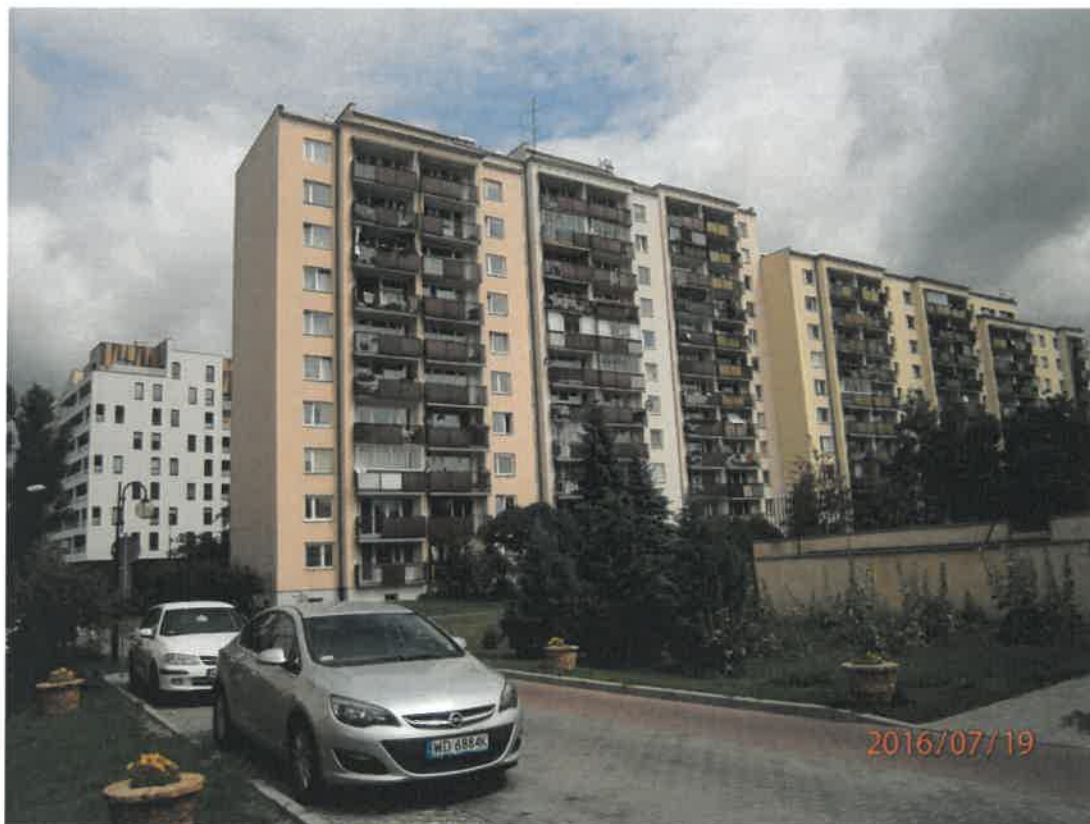
fot. balustrady balkonowe w budynku Sternicza 131 przed remontem
