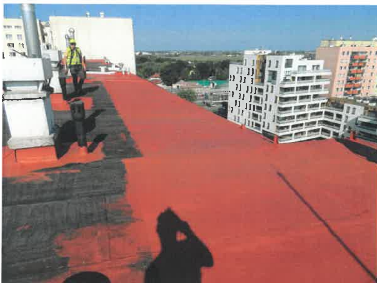
Fot. Układanie warstwy
