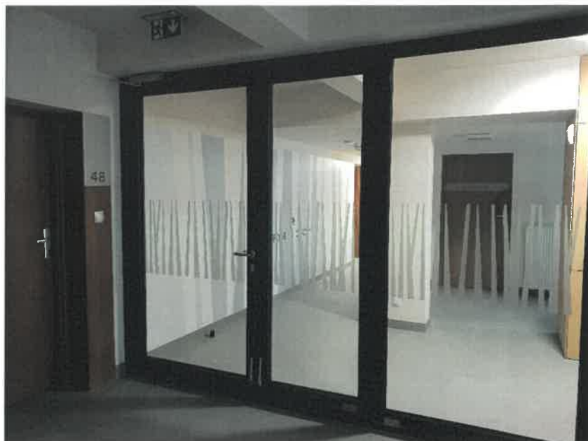
Fot.4. Widok korytarza na parterze budynku B1
