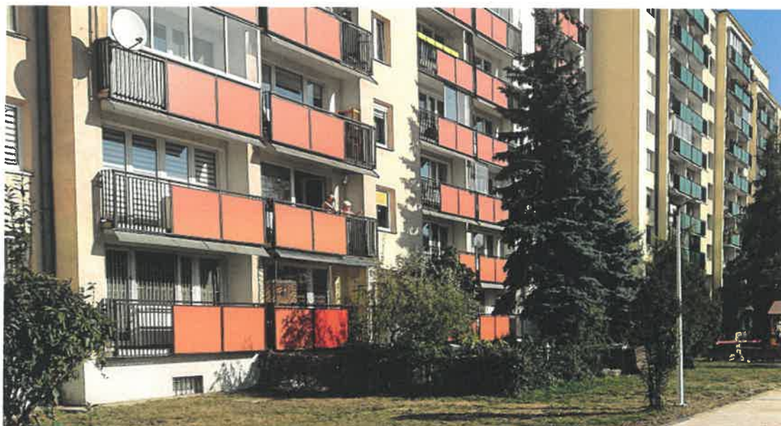
fot. Sternicza 129 i 131 -balustrady po remoncie
