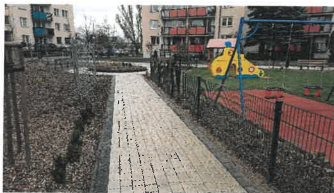
Fot.: etap III rewitalizacji – nowa nawierzchnia, świeżo posadzona zieleń i zmodernizowany plac zabaw przy Sterniczej
