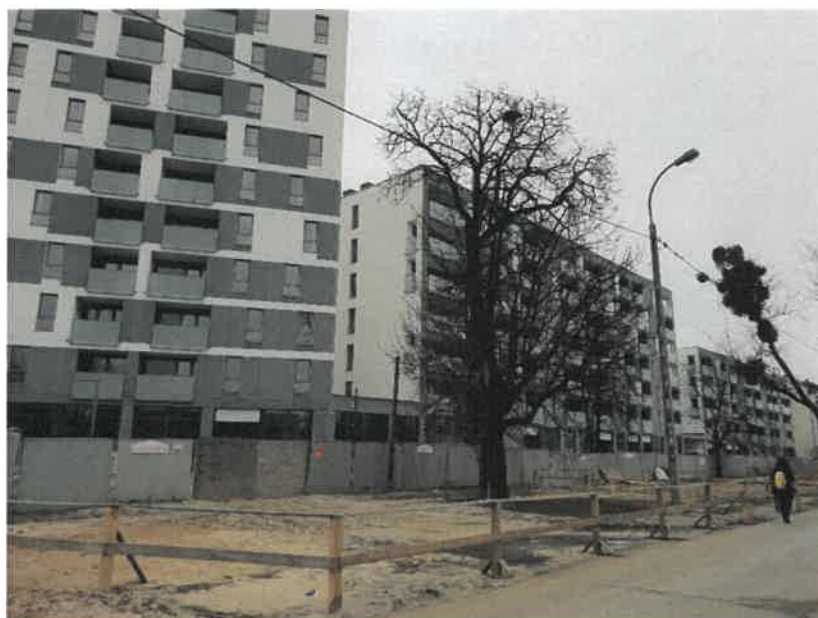
Fot.5. Widok budynku B2, B3 i B4 od strony ul. Szeligowskiej
