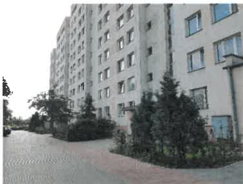
Fot.: nasadzenia przed kłatkami budynku Rozłogi 2
