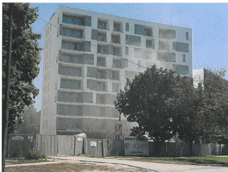
Fot.4. Widok budynku B4 od strony ul. Szeligowskiej
