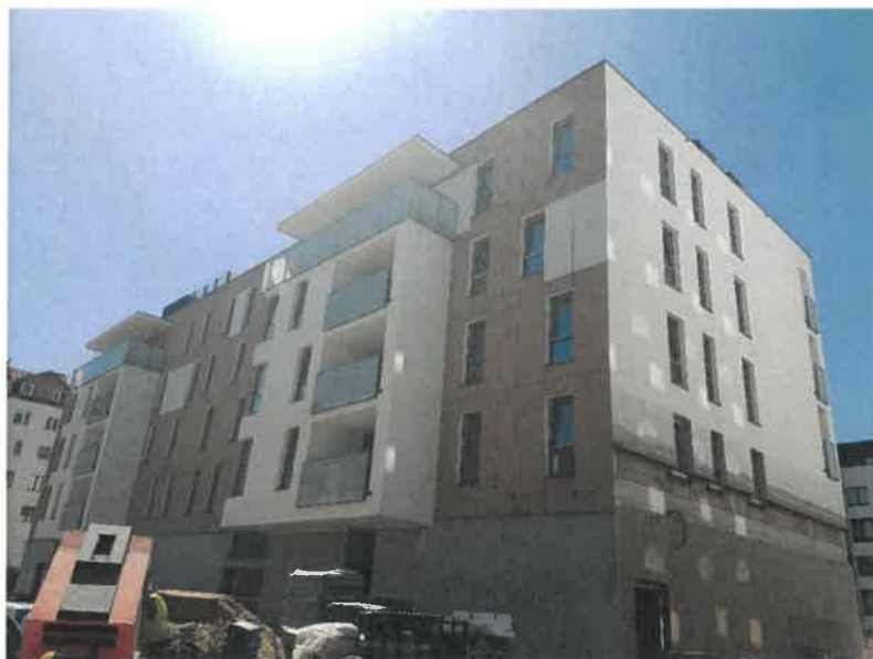
Fot.2. Widok budynku B2 od strony wschodniej
