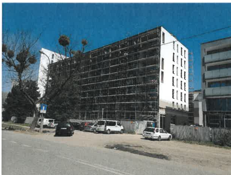
Fot.3. Widok budynku B3 od strony ul. Szeligowskiej
