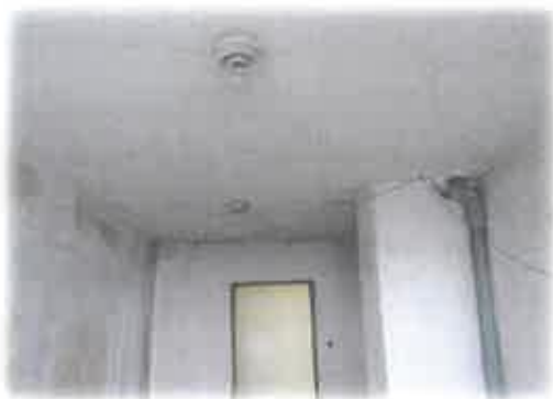
Suszarnia przed remontem
