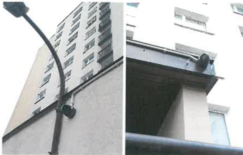
Fot. 9: Nowe kamery przy wejściu do budynku Lazurowa 2a
