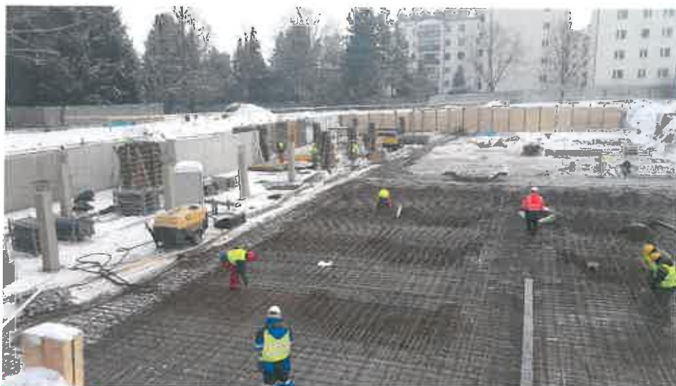
Fot.1. Zbrojenie płyty fundamentowej budynku B1
