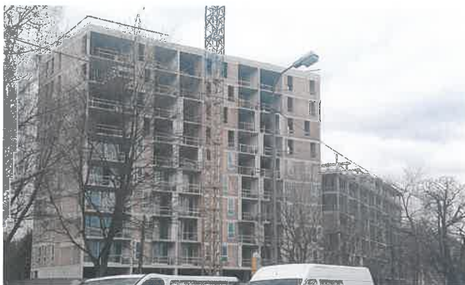
Fot.1. Widok budynku B4 i B3 od strony ul. Szeligowskiej
