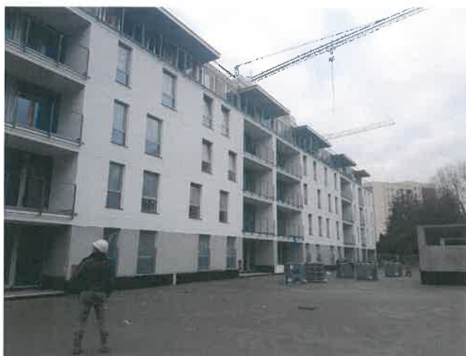
Fot.2. Elewacja tylna budynku B1
