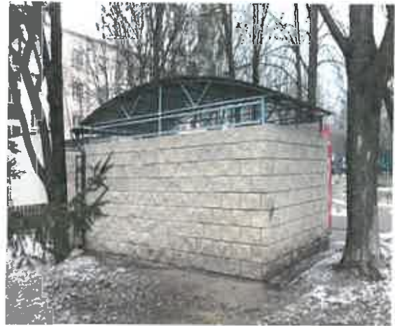
Odbudowana altana śmietnikowa.
