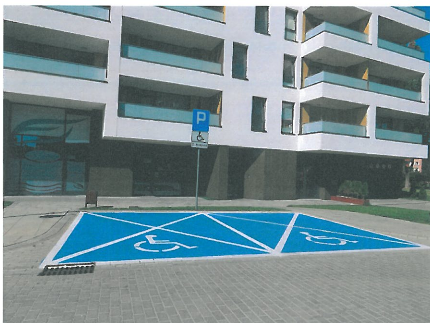
Rys. 2.: Zdjęcie wykonanego oznakowania poziomych miejsc postojowych.
