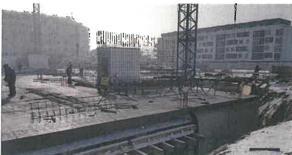
Fot.2. Budynek B1 – poziom 0 (15 luty 2017r.)
