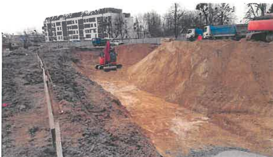
Fot.3. Roboty ziemne – wykop pod budynek B3 i B4 (15 marca 2017r.)
