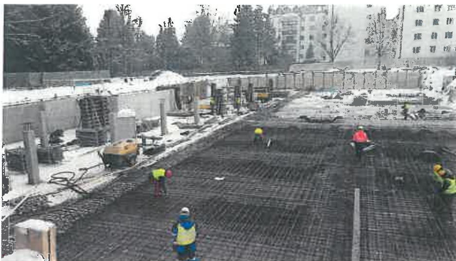
Fot.1. Zbrojenie płyty fundamentowej budynku B1 (18 stycznia 2017r.)
