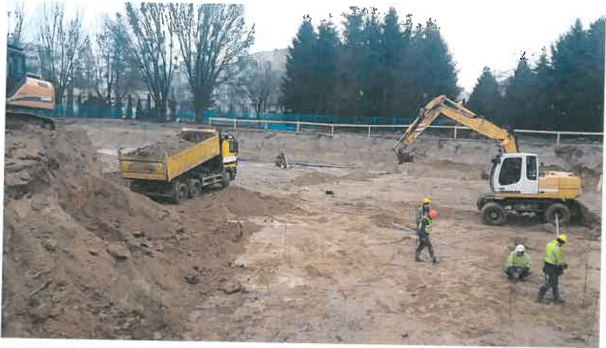
Fot. 3. Roboty ziemne – wykop pod bud. B1
