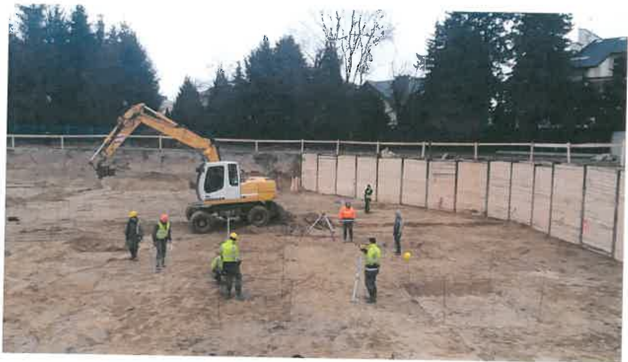
Fot. 4. Roboty ziemne – wykop pod bud. B1, ścianka berlińska str. południowa
