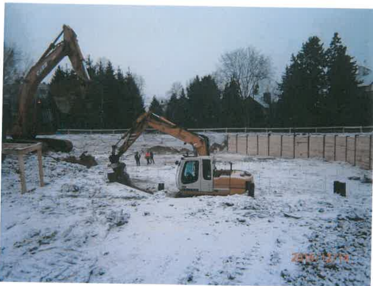
Fot. 5. Roboty ziemne – wykop pod bud. B1, ścianka berlińska str. południowa
