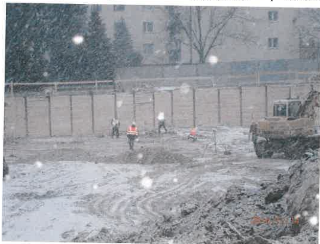
Fot. 6. Roboty ziemne – wykop pod bud. B1, ścianka berlińska str. południowa
