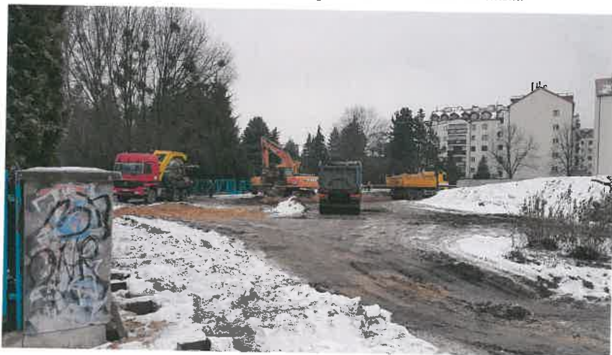
Fot. 2. Roboty ziemne – budynek B1
