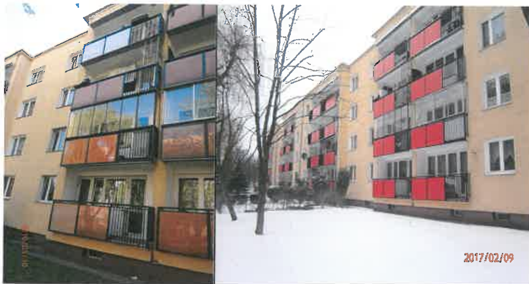
Fot. Pion balkonów od strony południowej w budynku Rozłogi 3 przed i remoncie.
