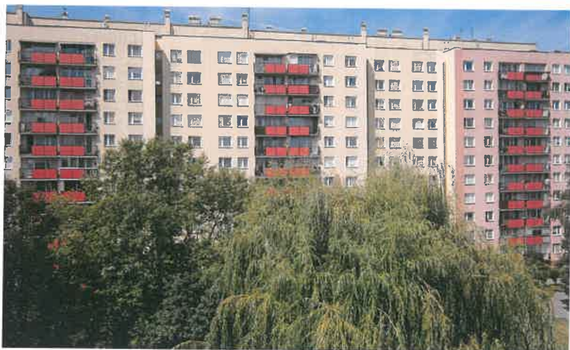
Fot. Lazurowa 4 wyremontowane balustrady balkonowe- elewacja wschodnia
