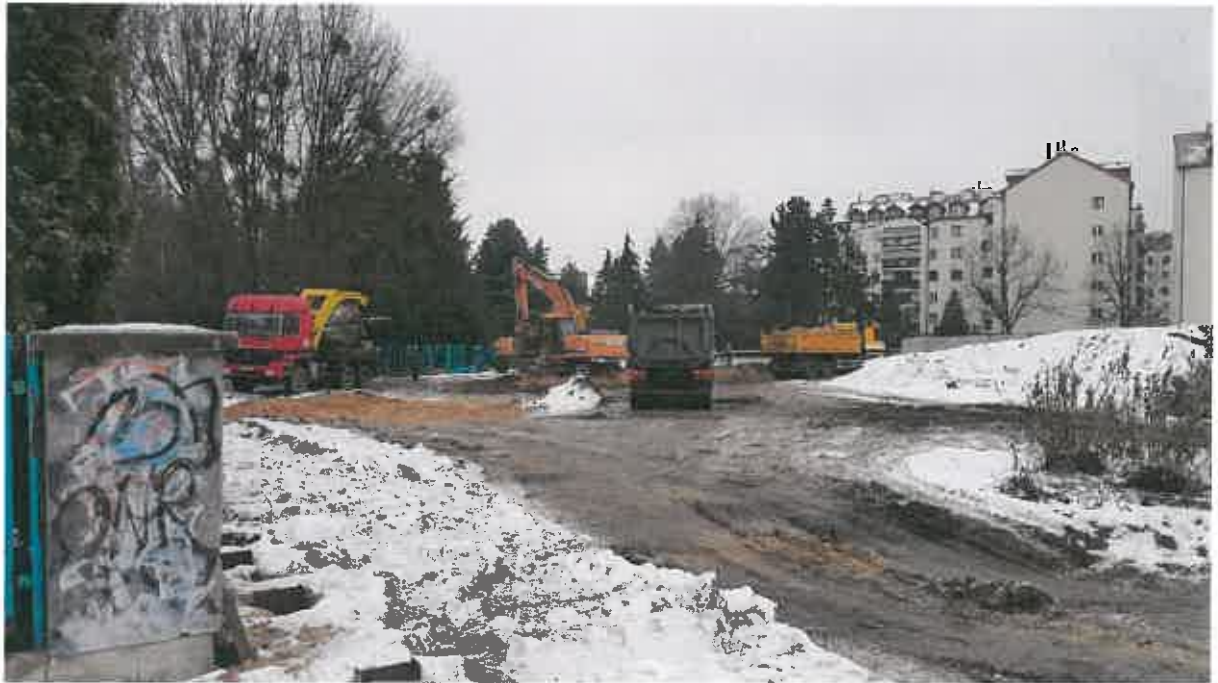
Fot. 2. Roboty ziemne – budynek B1
