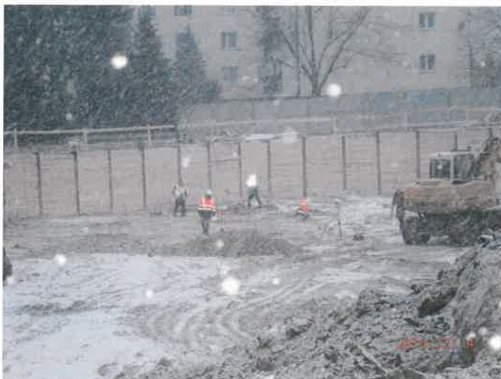
Fot. 6. Roboty ziemne – wykop pod bud. B1, ścianka berlińska str. południowa
