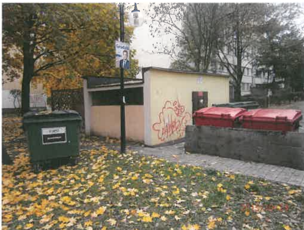
Fot. Altana śmietnikowa przy budynku Rozłogi 3,5,7 przed remontem - elewacje wschodnia i północna
