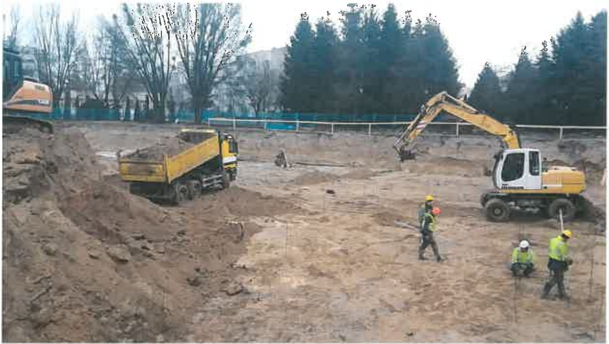
Fot. 3. Roboty ziemne – wykop pod bud. B1
