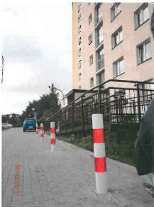
Fot. Słupki na wyremontowanym ciągu przed budynkiem Lazurowa 2A
