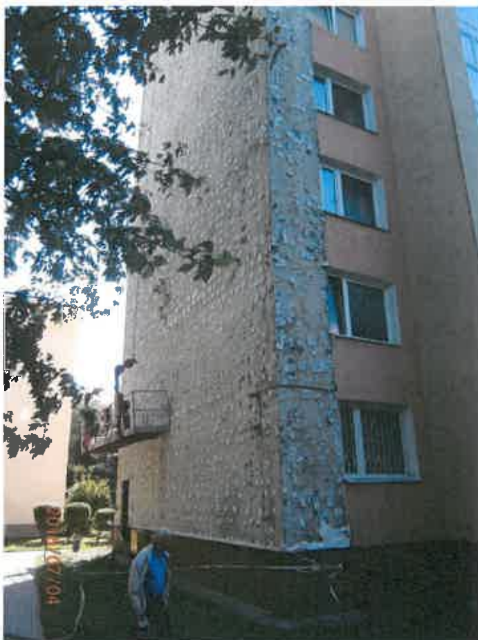
Fot. Elewacja północna budynku Lazurowa 4 po demontażu warstwy docieplenia.
