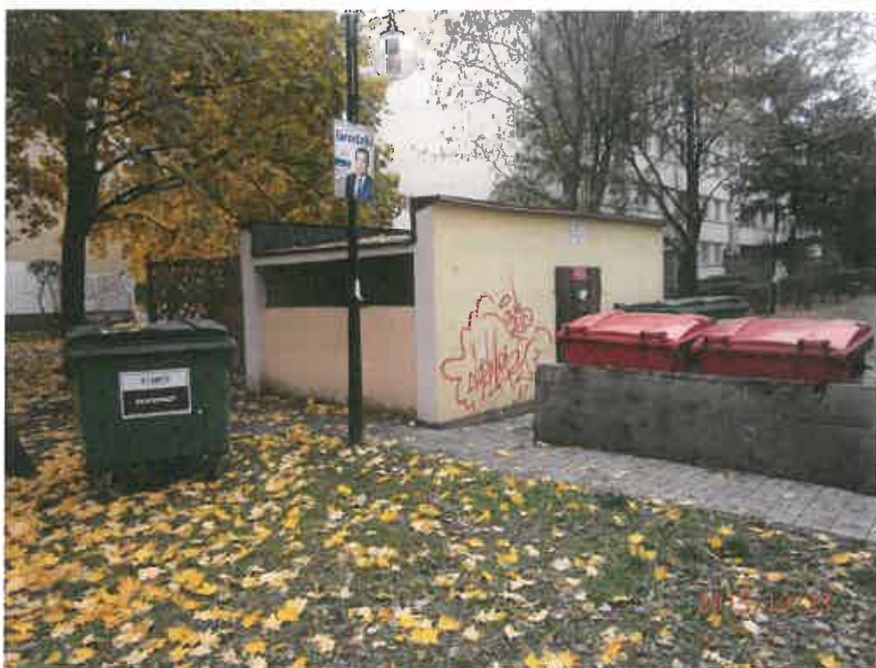
Fot. Altana śmietnikowa przy budynku Rozłogi 3,5,7 przed remontem - elewacje wschodnia i północna
