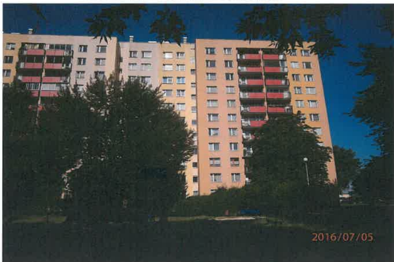
Fot. Wyremontowany pion balkonów w budynku Lazurowa 4.
