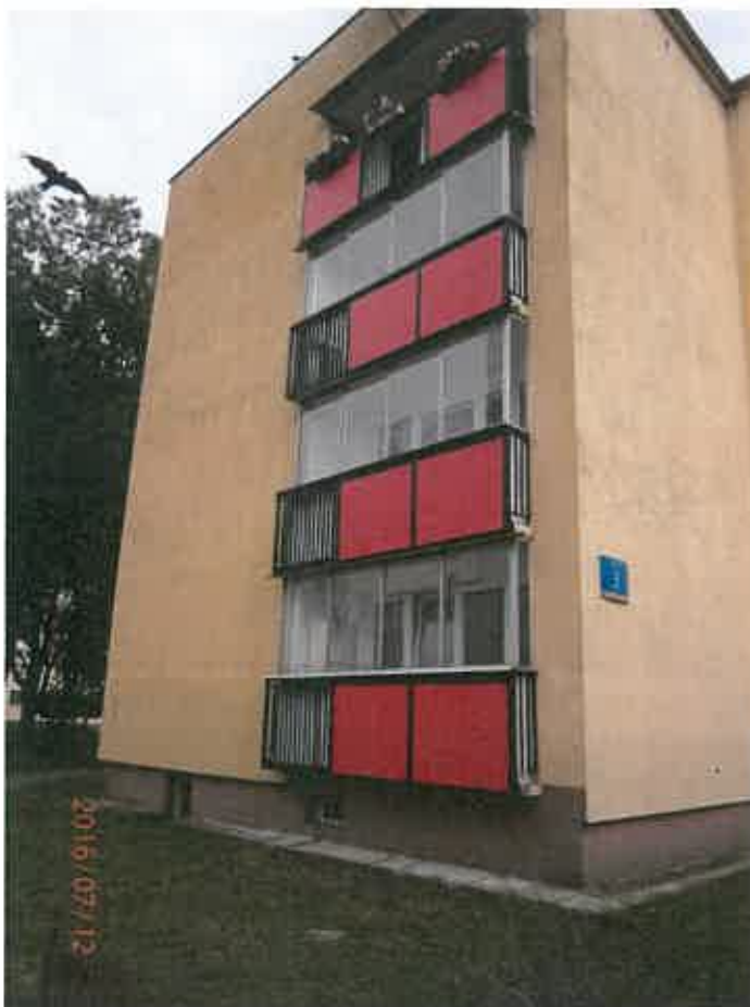
Fot. Wyremontowany pion balkonów od strony południowej w budynku Rozłogi 3
