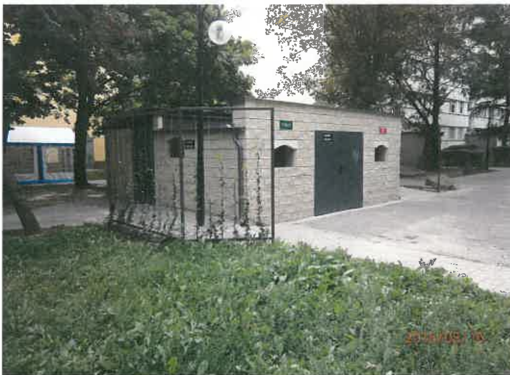
Fot. Altana śmietnikowa przy budynku Rozłogi 3,5,7- elewacje wschodnia i północna po remoncie z pergolą zaprojektowaną przez Administratora Osiedla Panią Agatę Markowiak.
