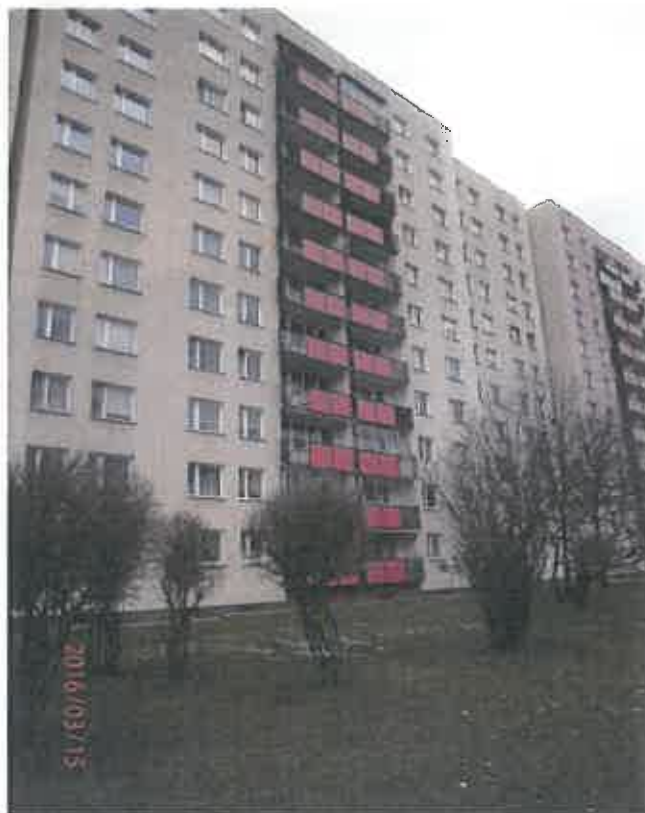
Fot. Wyremontowany pion balkonów w budynku Lazurowa 4.
