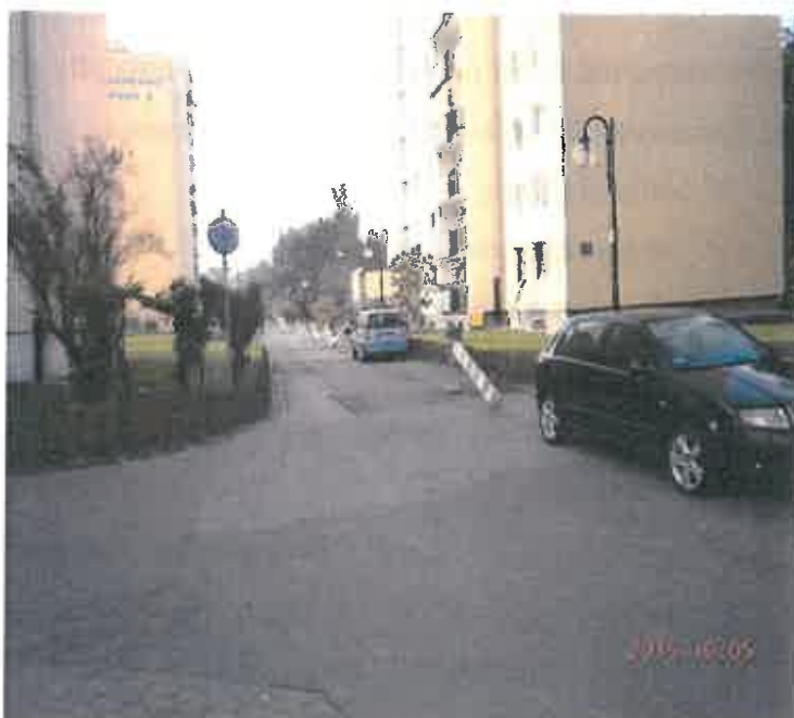
Fot. Ciąg pieszo-jezdny Lazurowa 2 i 2a przed remontem
