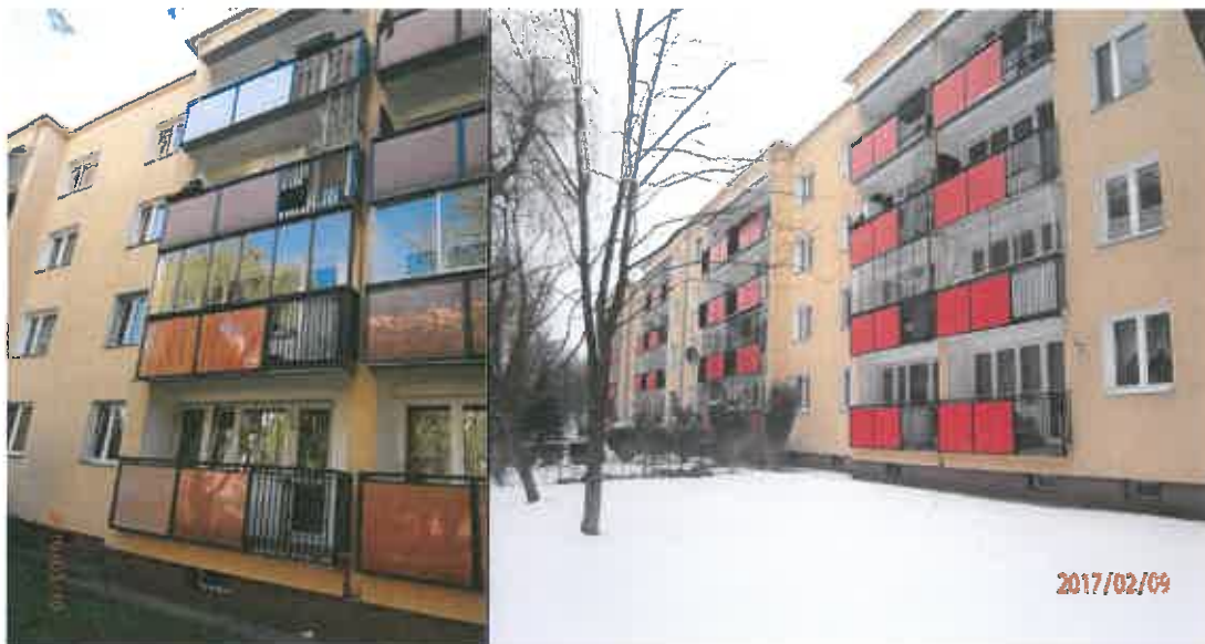
Fot. Pion balkonów od strony południowej w budynku Rozłogi 3 przed i remoncie.
