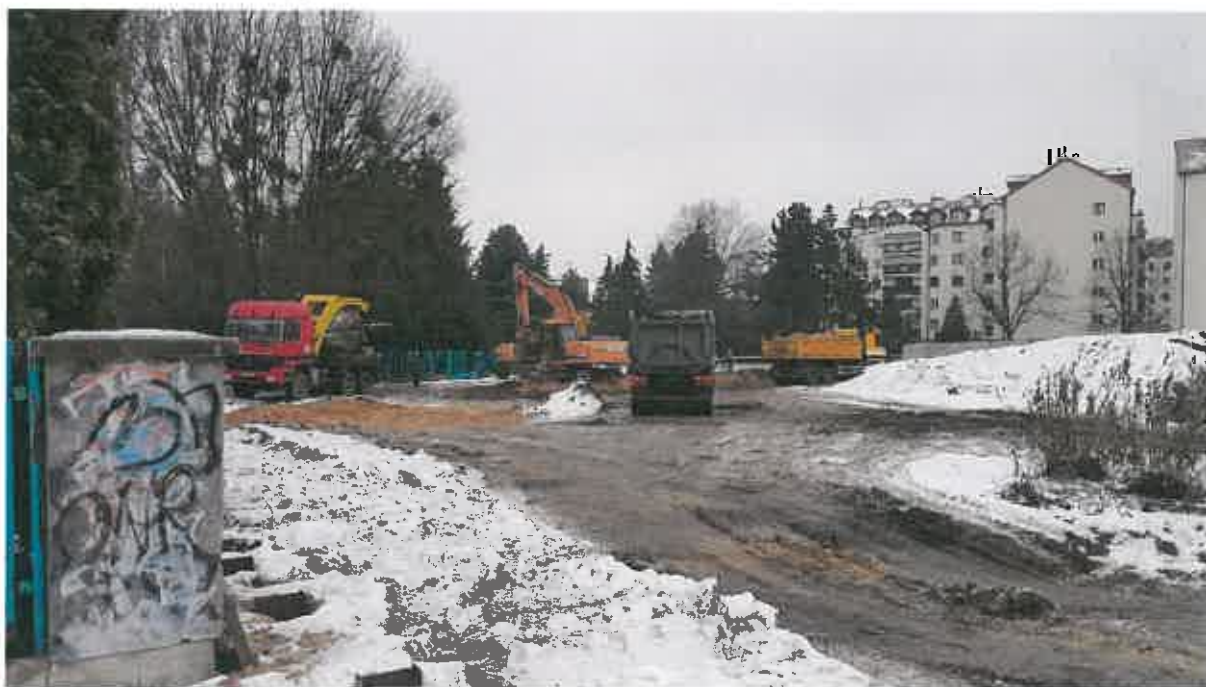
Fot. 2. Roboty ziemne – budynek B1
