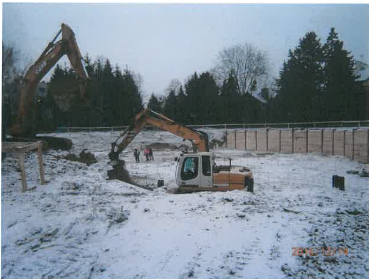
Fot. 5. Roboty ziemne – wykop pod bud. B1, ścianka berlińska str. południowa
