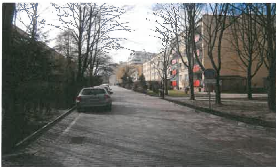
fol. wyremontowany ciąg pieszo-jezdny prze budynkiem Rozłogi 3
